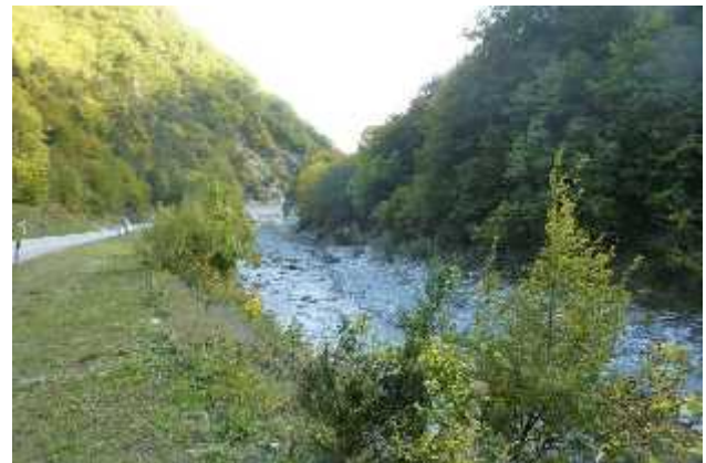
Difesa spondale lungo il tratto.
