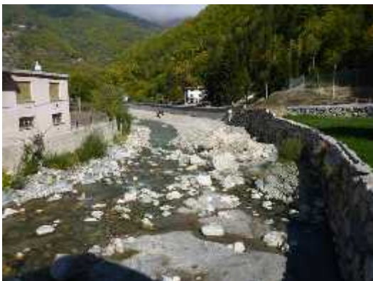
In destra, opere di difesa realizzate a seguito dell'evento alluvionale di novembre 2016.
