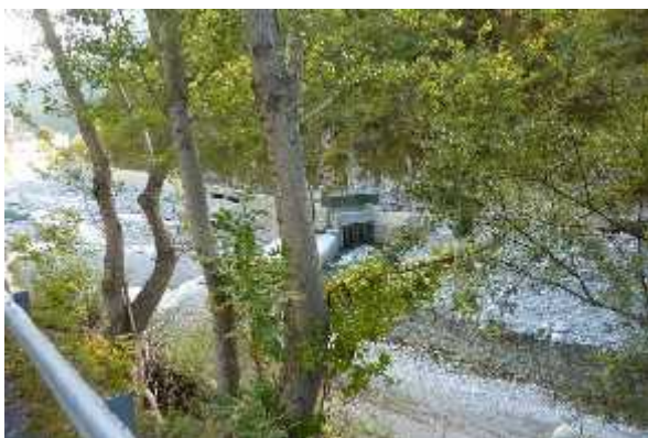
Traversa di derivazione in località Ponte di Nava.
