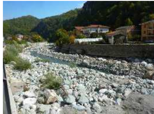
Muri di difesa spondale nel tratto in ingresso all'abitato di Ormea.
