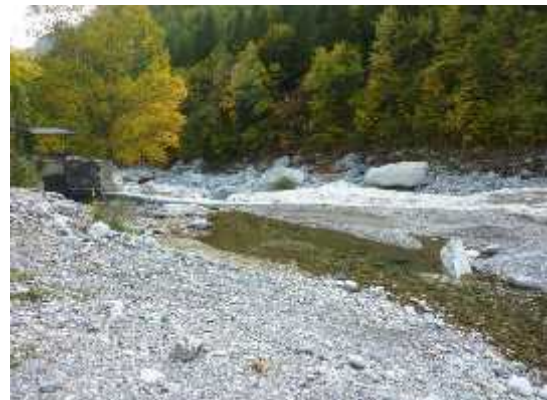
Traversa di derivazione in località Ponte di Nava.
