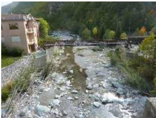
Parte iniziale del tratto in località Ponte di Nava.
