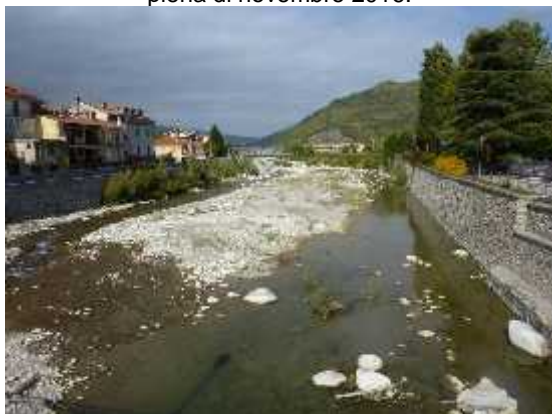
Vista verso valle dal ponte Odasso.
