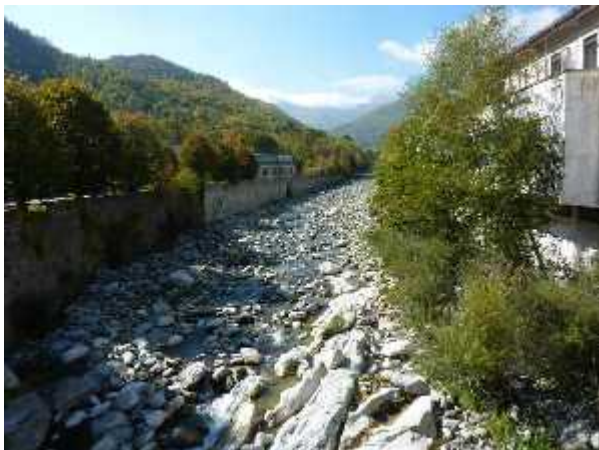
Difese spondali in corrispondenza dell'ex cartiera.
