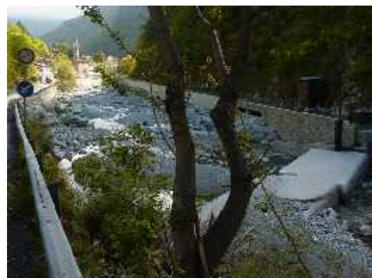
Parte conclusiva del tratto, in località Ponte di Nava.
