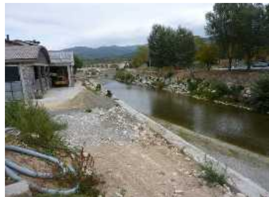
Difese spondali a monte del ponte Romano di Bagnasco.
