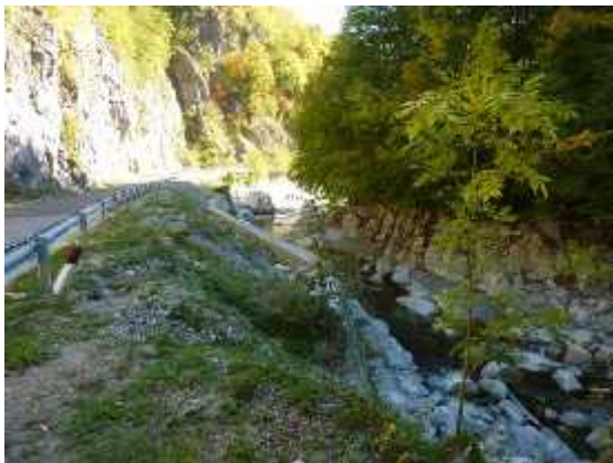
Difesa spondale lungo il tratto.
