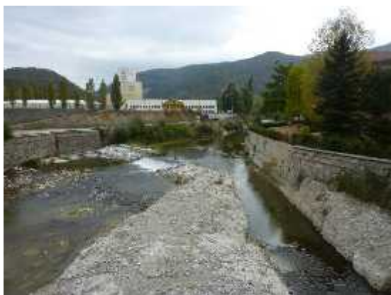
Vista del tratto a monte del ponte Romano di Bagnasco.
