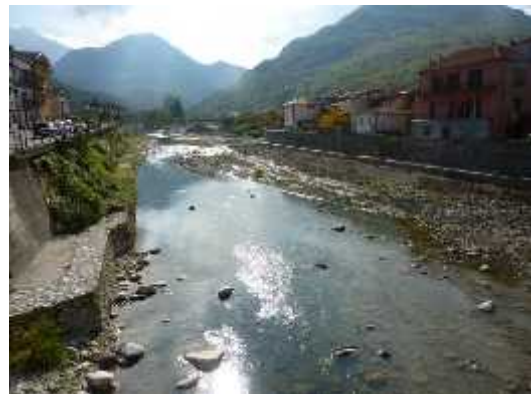
Vista verso monte dal ponte Odasso.
