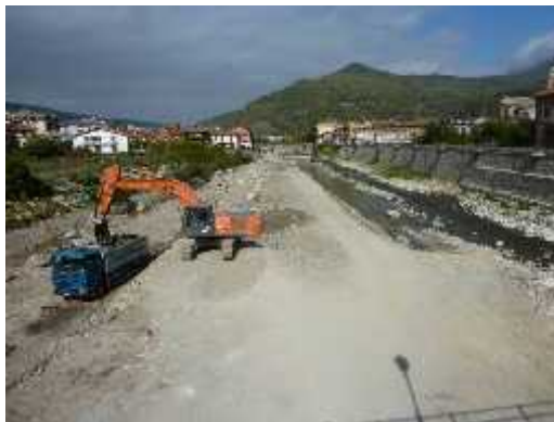
Vista verso valle della tratto in ingresso nell'abitato di Garesio. In primo piano i lavori di disalveo a seguito della piena di novembre 2016.
