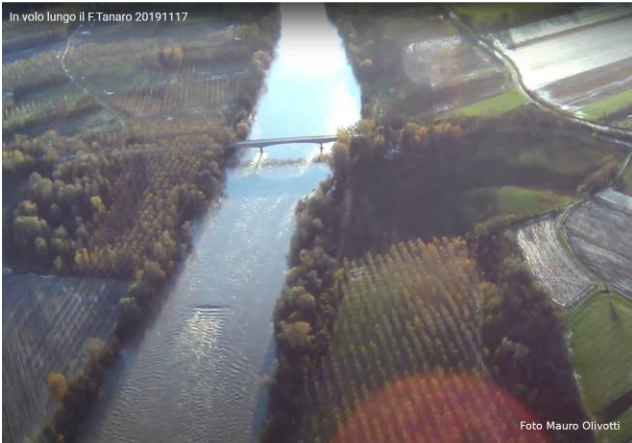
Bassignana: ponte della SP 80
