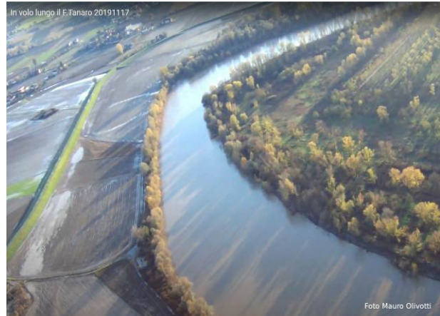
Bassignana: dettaglio difese spondali e argini.
