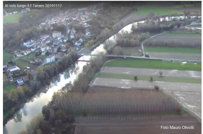
Masio: ponte della SP 247 .
