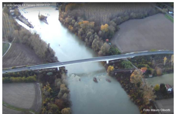
Felizzano-Masio: ponte della SP77.
