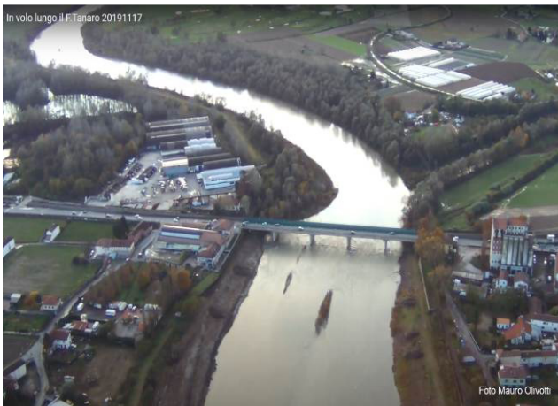
Asti ponte stradale di Corso Savona.
