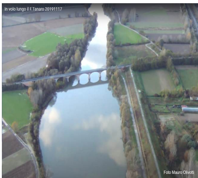
Castello di Annone: ponte della SP 39.
