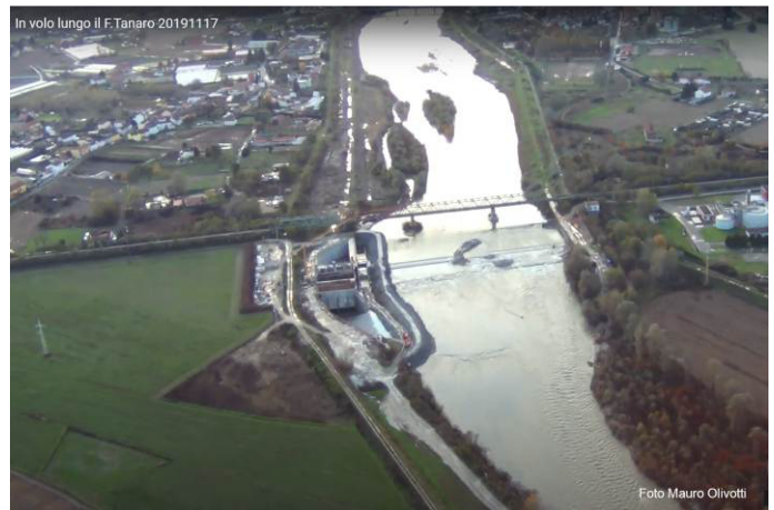
Asti, ponte ferroviario e traversa centrale idroelettrica Tanaro .
