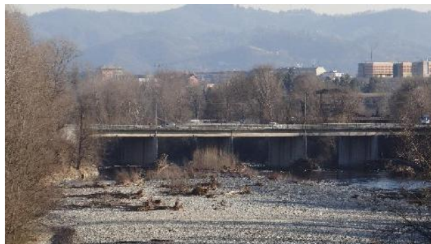
Ponte di Strada dell'Aeroporto.
