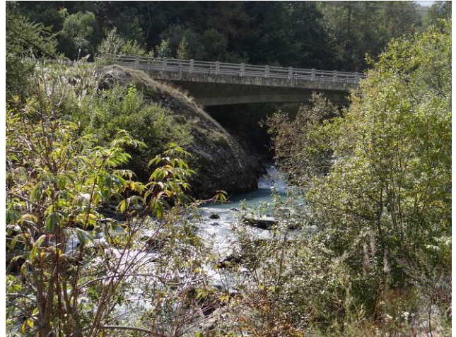
Ponte a monte di Fraz. Chialambertetto
