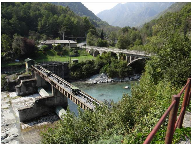
Traversa in località La Fabbrica, a valle di Almesio e Voragno.
