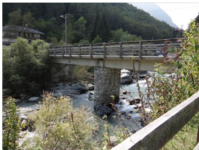
Ponte a valle di La Fabbrica, Ala di Stura
