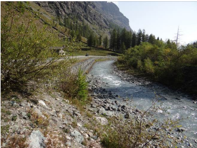
Difese in sponda sinistra a protezione della strada a valle di Grange della Mussa
