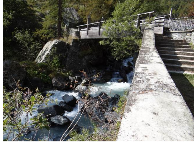
Passerella pedonale in corrispondenza di Bogone
