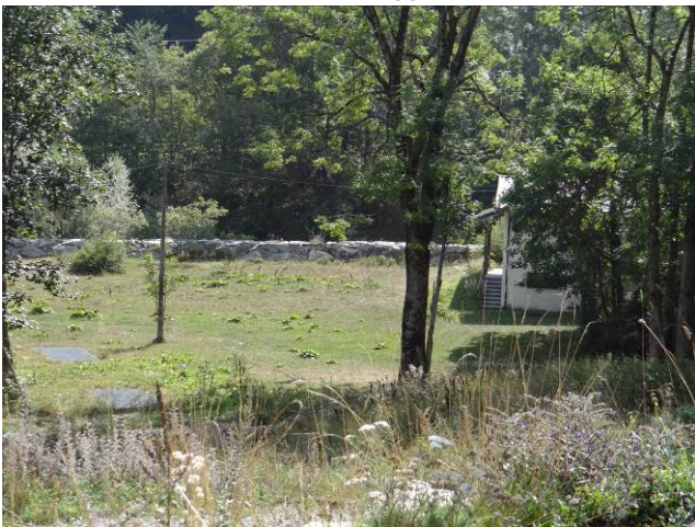
Argine in sponda sinistra a monte dell'abitato di Chialambertetto
