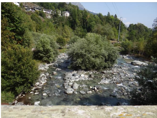
Alveo in corrispondenza di Martassina, visto dal ponte di Fraz. Tomà
