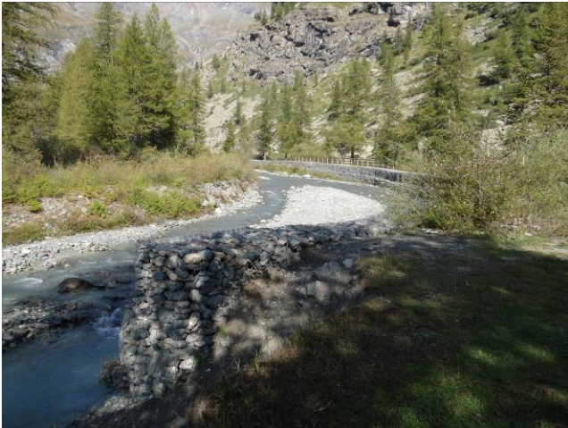
Argine in sponda sinistra presso località Ghiaiarone
