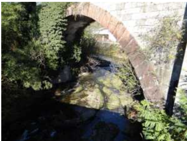
L'alveo all'altezza del ponte della SP 75.
