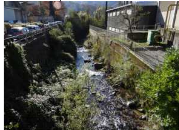
Vista delle difese spondali in via Orlonghetto, Valduggia.
