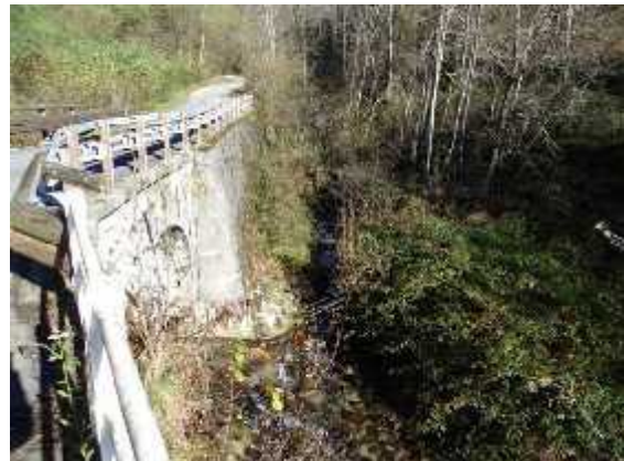
Ponte della strada SP 103.
