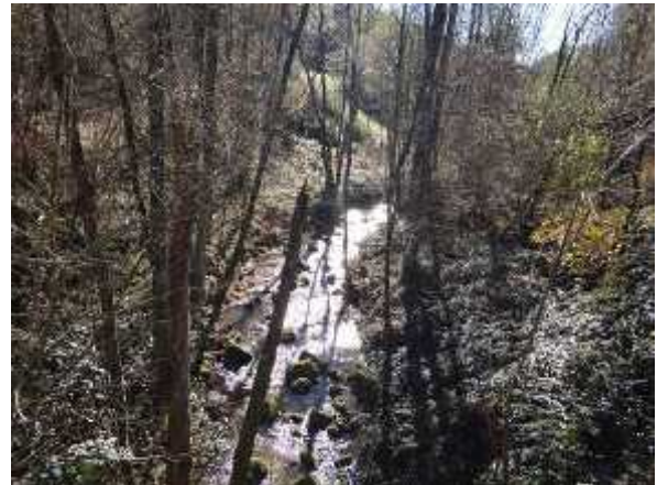
L'alveo a valle del ponte.
