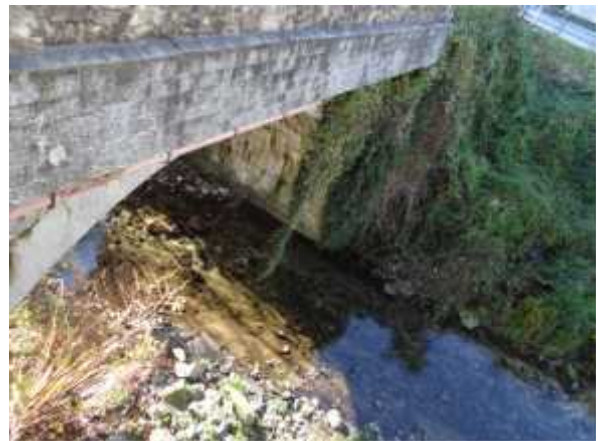
Il ponte della SP 76.
