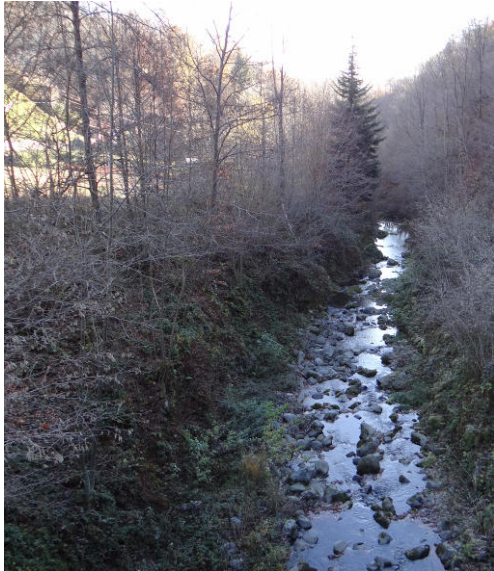
Alveo a valle del ponte della Sp 106, fraz. Molino
