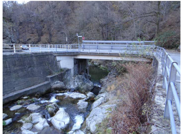
Ponte fraz. Picco (Rovella)
