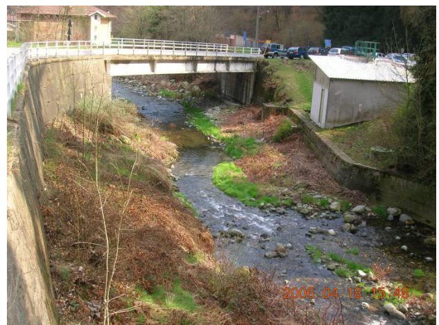
Ponte e difese spondali a valle lanificio Barbera (Studio Mello Rella & Associati)
