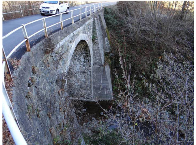
Ponte della SP 106 in fraz. Molino
