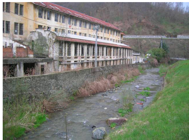
Difese spondali e muro arginale ex Ianificio Picco
