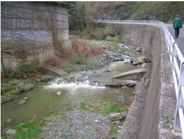
Soglia a monte del ponte Rovella (Studio Mello Rella & Associati)
