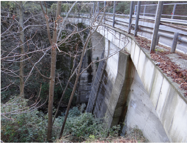
Ponte della SP 105
