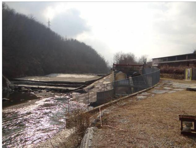
La traversa di derivazione ad uso idroelettrico passante al limite tra il tratto 2 e 3.
