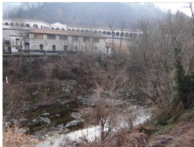
Opere di difesa costituite da scogliere in massi da cava.
