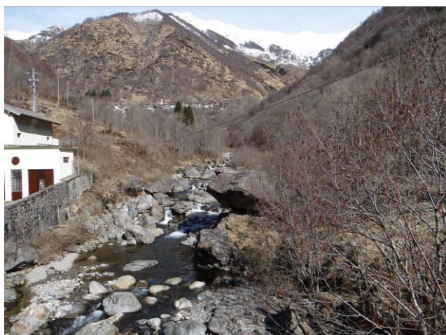
Alveo nei pressi della centrale Green Power.
