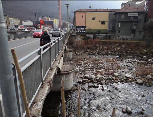
Ponte di via Fratelli di Dio.
