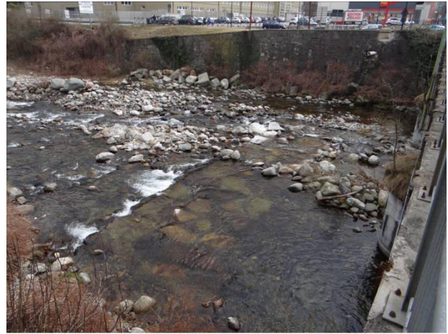
Una delle soglie a difesa dall'erosione di fondo nella parte terminale.
