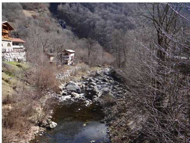
Difese spondali in sponda sinistra a difesa di alcune abitazioni di Forno.
