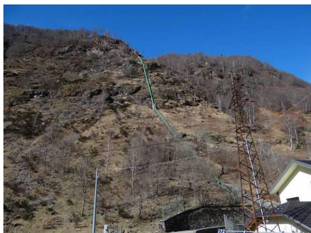
La condotta di derivazione.
