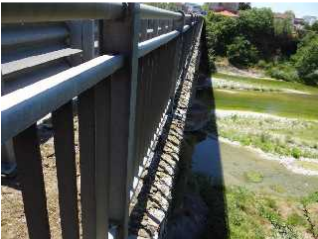
Ponte Ponte SS 35 per Cassano Spinola
