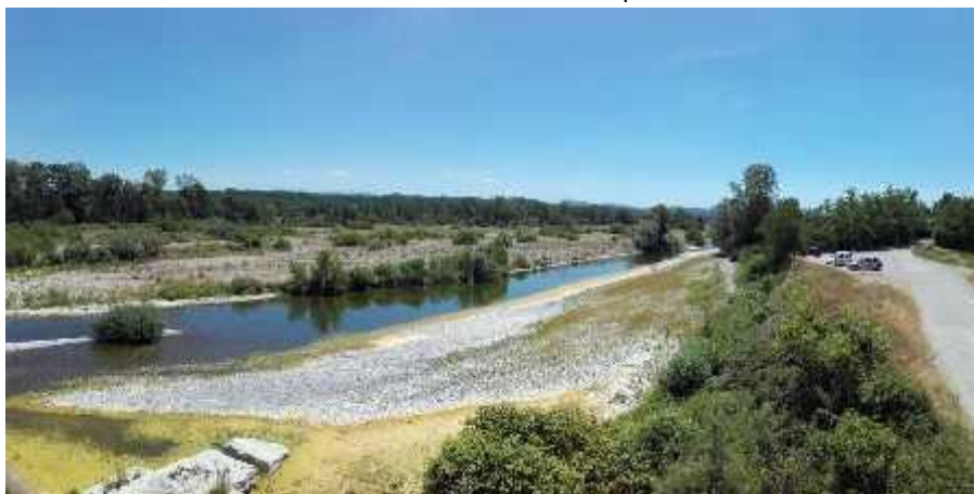
Alveo a monte del ponte SP151 .
