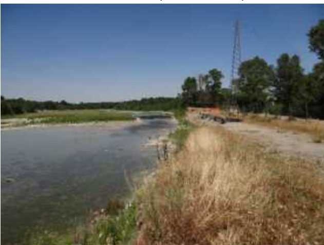
Sponda destra erosa
