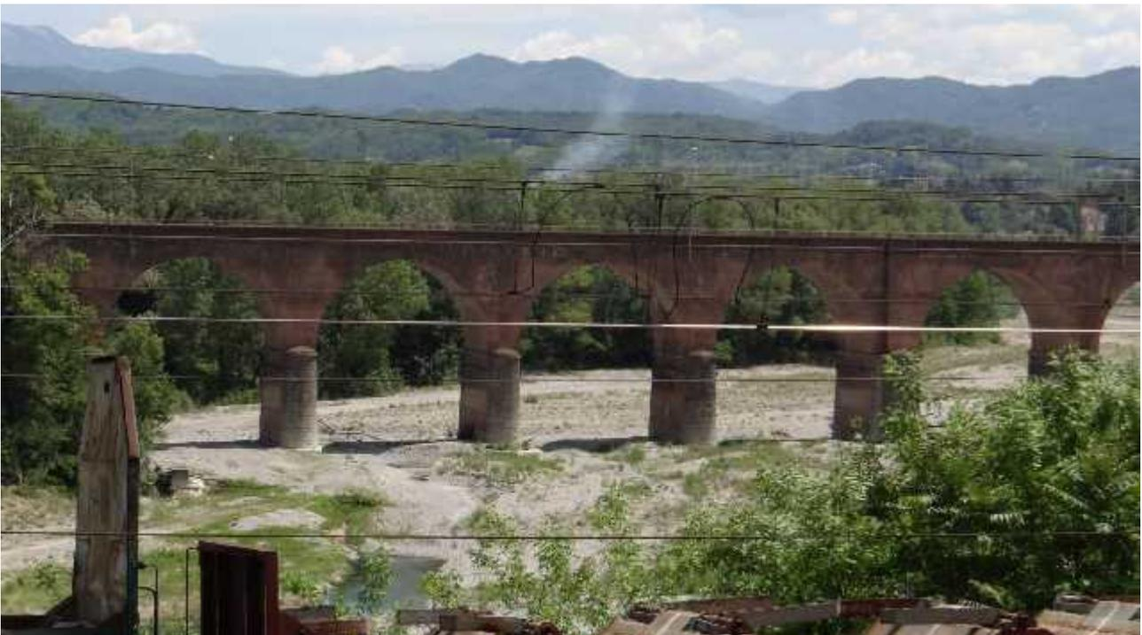
Ponte ferroviario, localmente si rilevano effetti di sovralluvionamento
