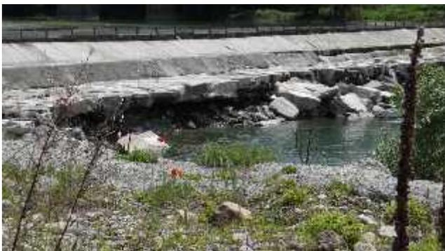
Traversa di Varinella: sottoescavazione per erosione del fondo
