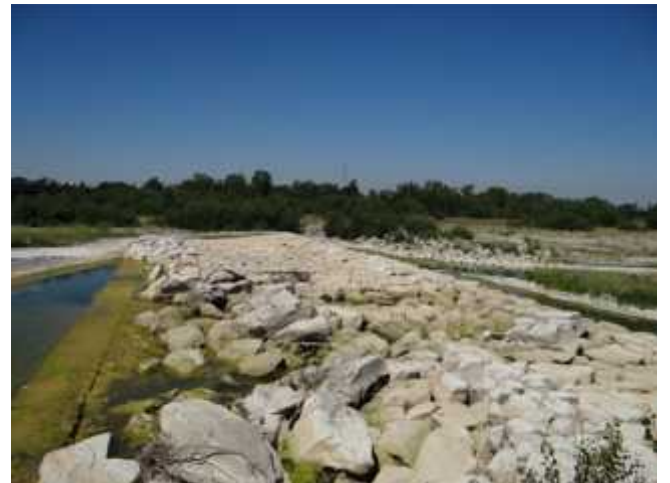
L'opera trasversale a valle dell'autostrada nei pressi di Tortona.
