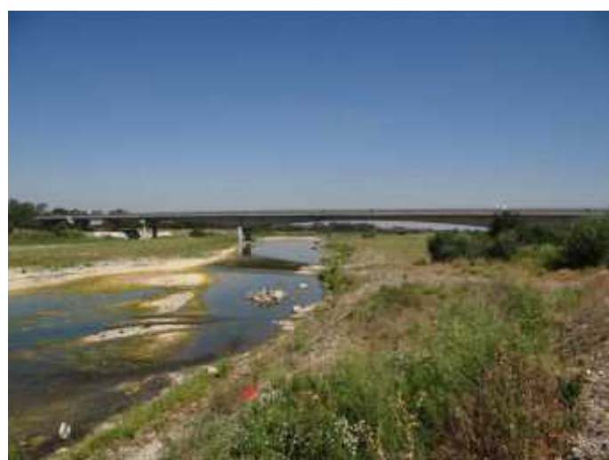
Il ponte della Tangenziale di Tortona.
