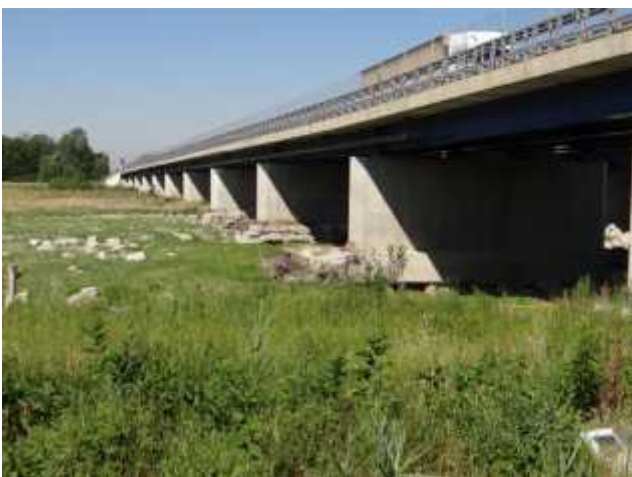
Viadotto della A7.
