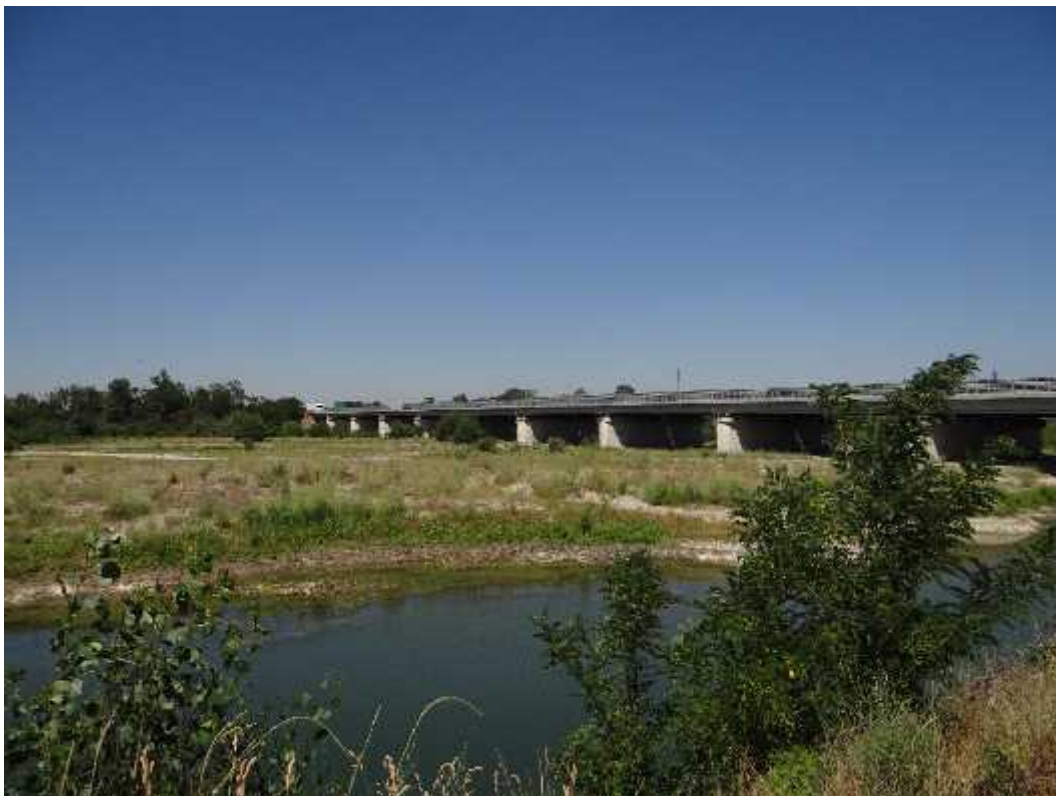
Il viadotto dell'autostrada A21 visto da monte.
