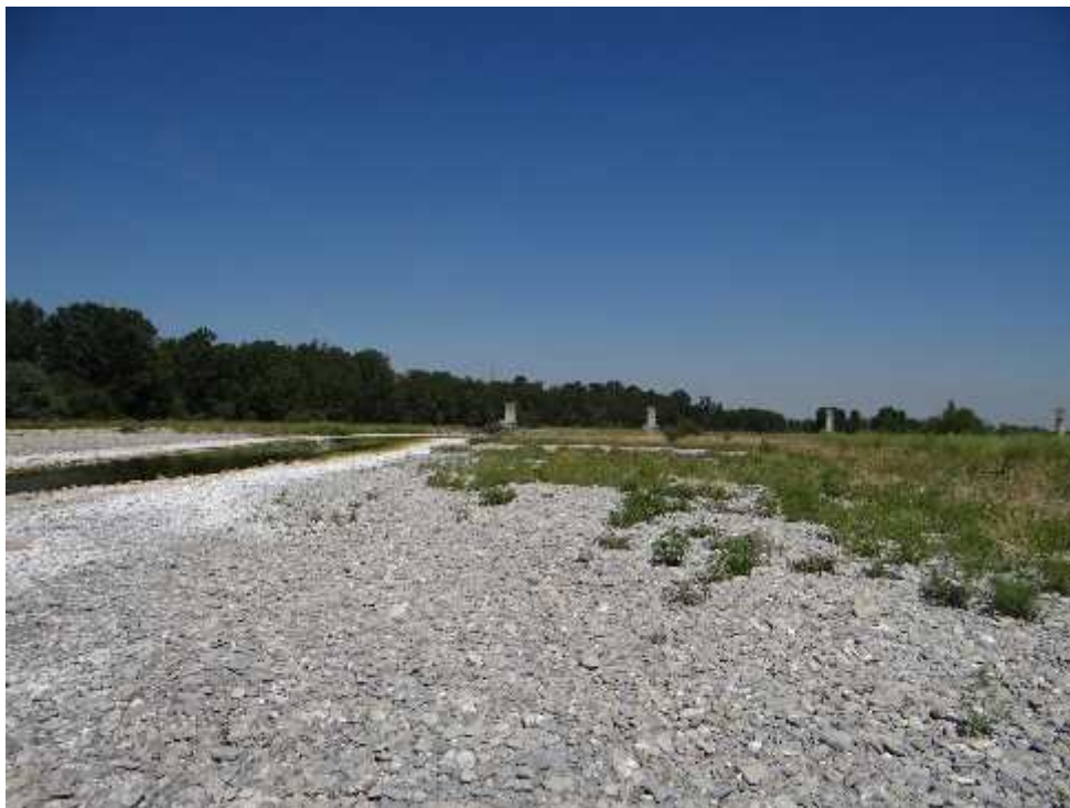
L'alveo in secca, giugno 2017, nei pressi dei piloni in disuso del metanodotto Tortona-Carbonara.
