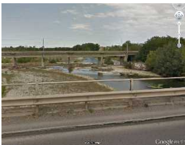
Il ponte della linea ferroviaria Voghera- Alessandria (Street View Google earth).
