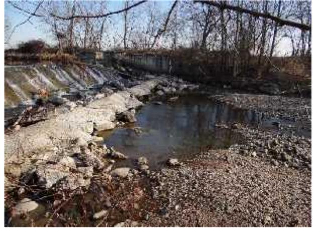
Erosione del fondo alveo subito a valle della traversa
