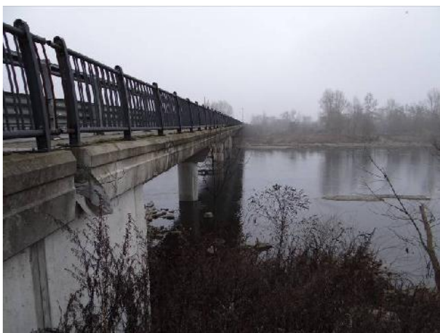
Ponte della SP 94.
