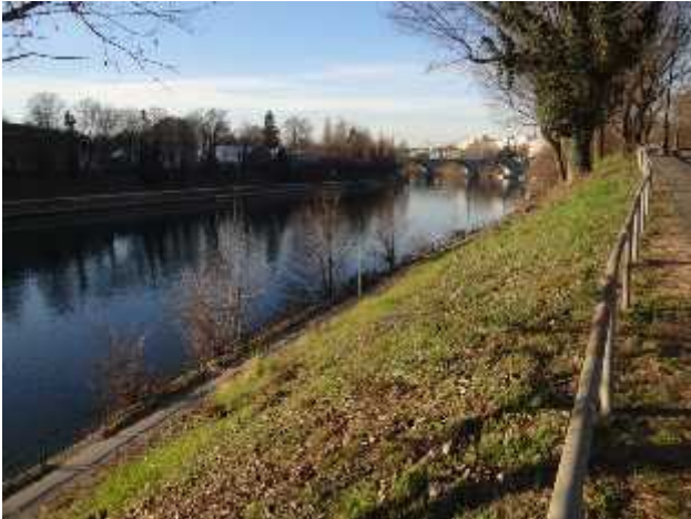
A monte di Ponte Balbis, vista dalla sponda sinistra
