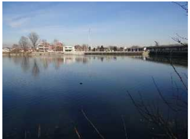
Confluenza Stura di Lanzo. Traversa a monte del tratto successivo
