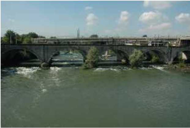
Ponti ferroviari e autostradale a Moncalieri visti dal ponte di Via Martiri della Libertà
