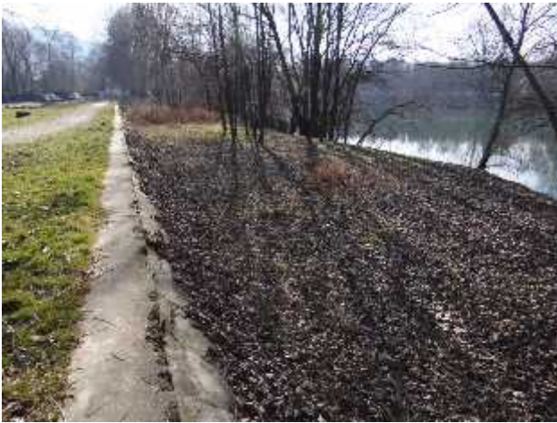
Argine sponda destra
