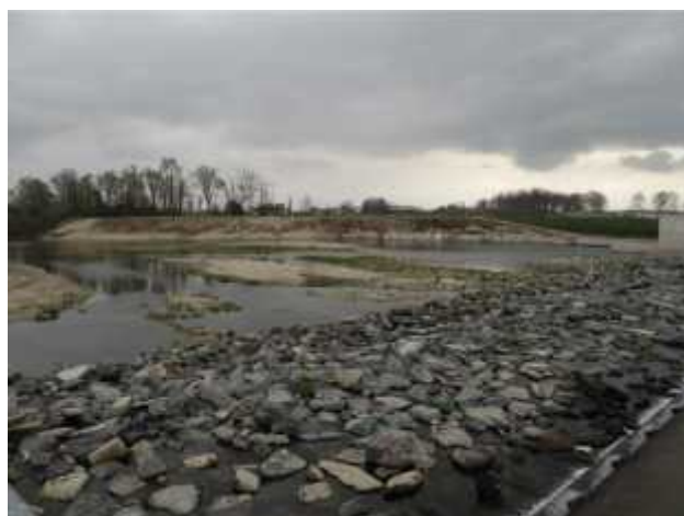
Sbarramento a servizio del canale di gronda.
