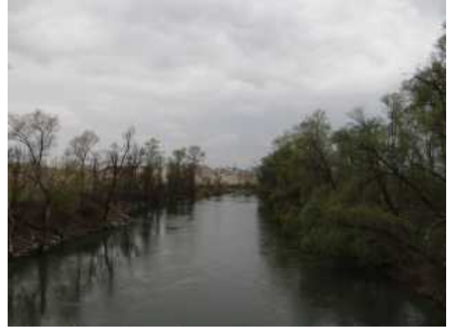
Vista a monte del Po dal ponte di Faule. Sulla sinistra della fotografia difese spondali costituite da massi ciclopici.
