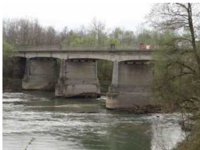
Le pile del ponte viste da valle.
