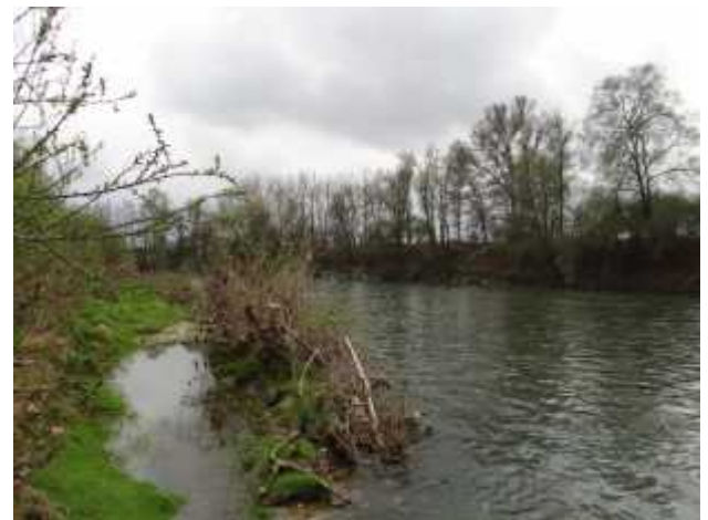
Vista a valle con in destra idrografica difese spondali in massi ciclopici.
