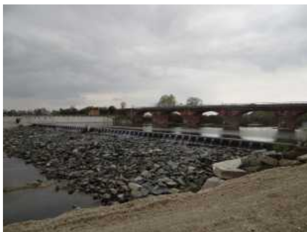
Il ponte sul torrente all'inizio del tratto.
