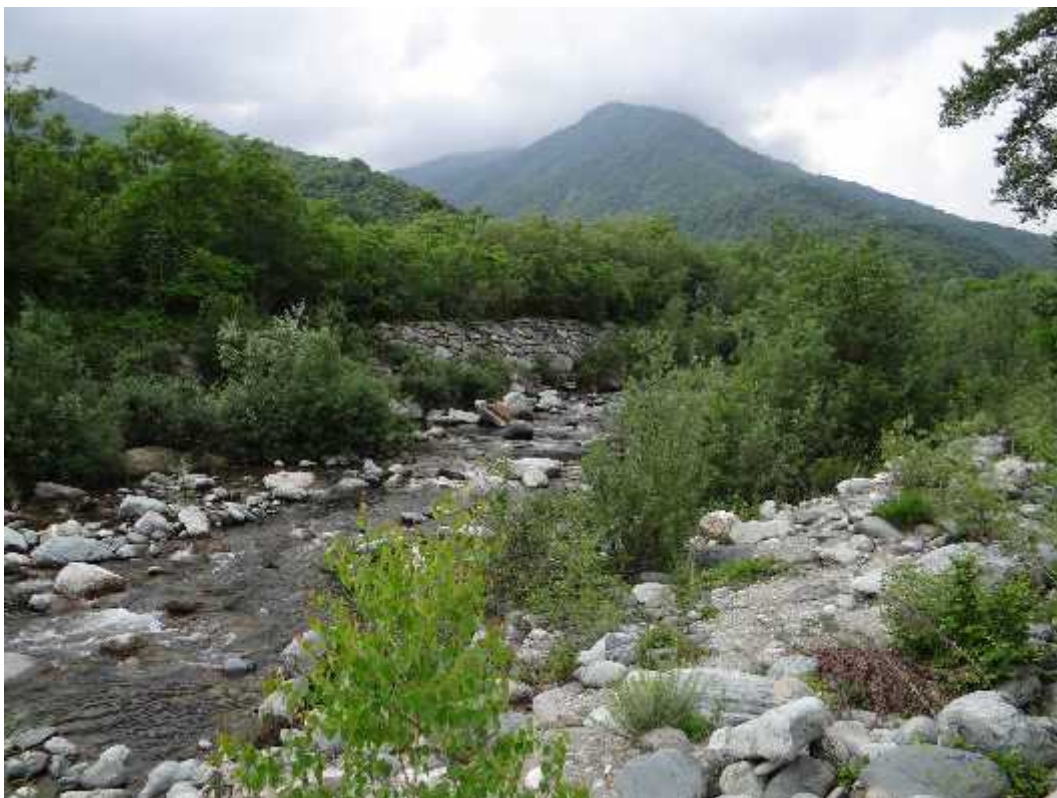
Figura 6 – Difese spondali a monte del ponte di Paesana
