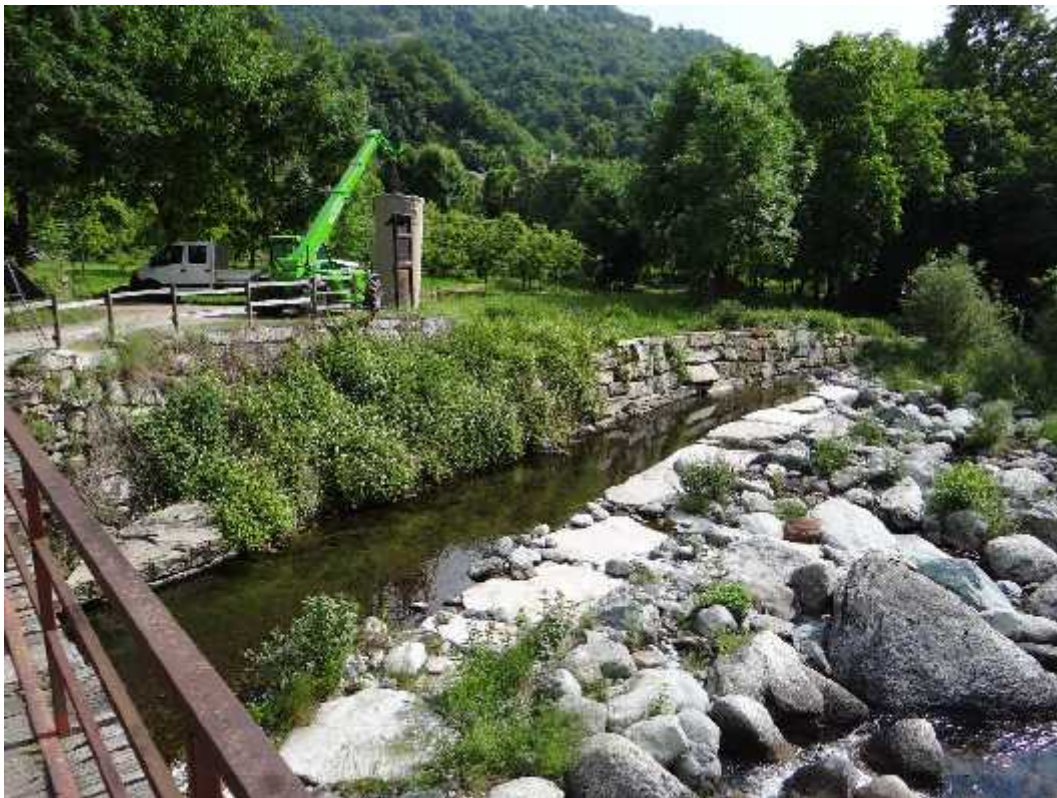
Figura 2 – Canale di derivazione a scopo irriguo in corrispondenza dell'attraversamento dell'immagine precedente
