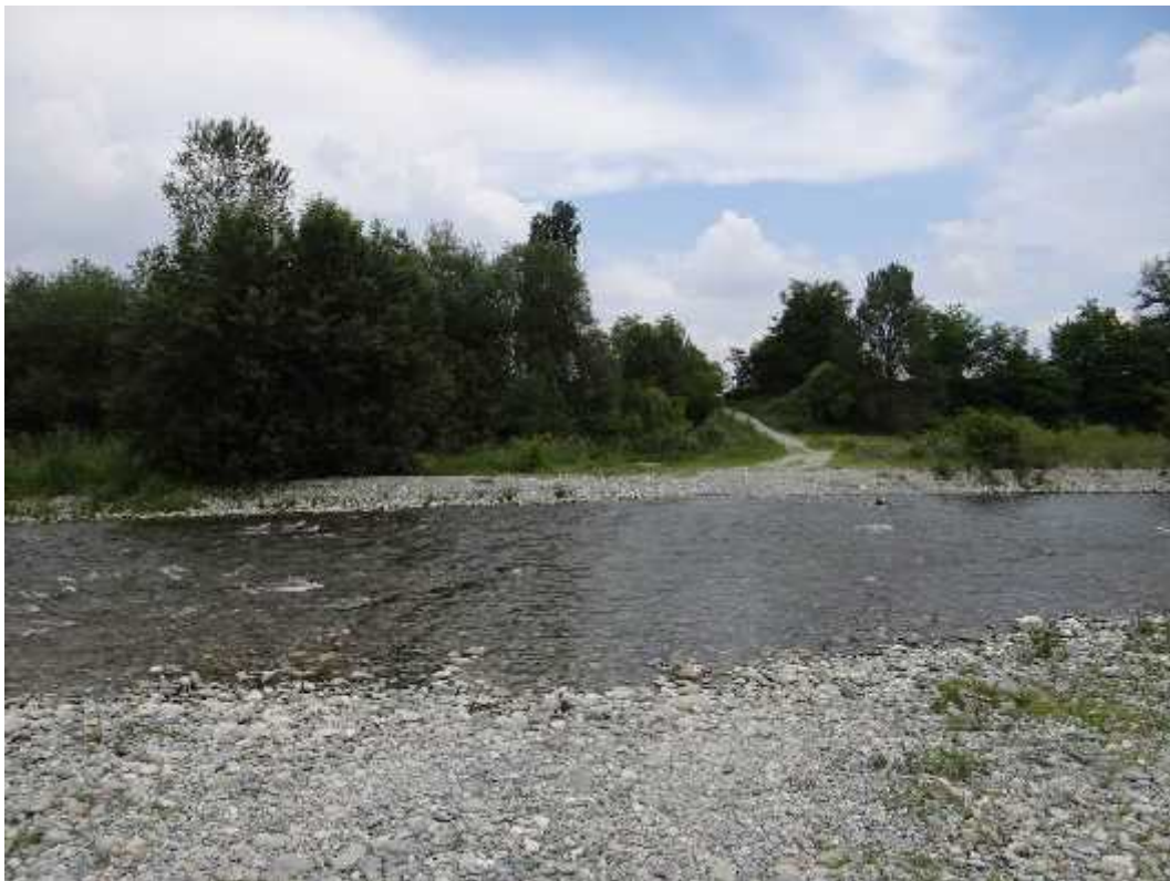
Figura 17 - Parte centrale del tratto; in secondo piano argine in sponda destra
