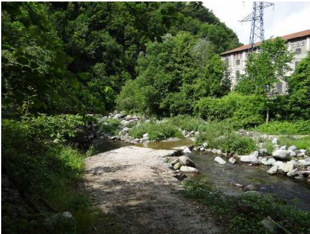
Figura 4 – Guado a valle della centrale idroelettrica
