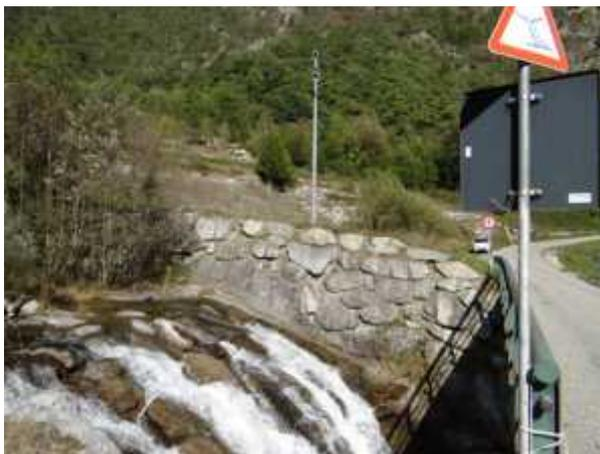
Il tratto di alveo, a monte e a valle del ponte è alterato per la presenza di rivestimento del fondo impermeabile (pietrame e massi cementati) e le sponde sono difese.
