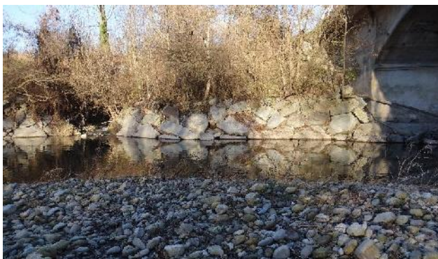
Difese spondali in corrispondenza del ponte su Strada Grattera
