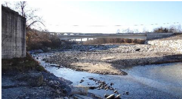
Opere di sistemazione alveo e sponde, in corrispondenza del ponte sulla SS 28
