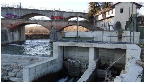
Opera di presa dell' impianto idroelettrico Carrù
