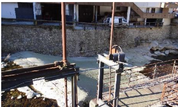
Traversa ad uso energetico, in frazione San Bartolomeo
