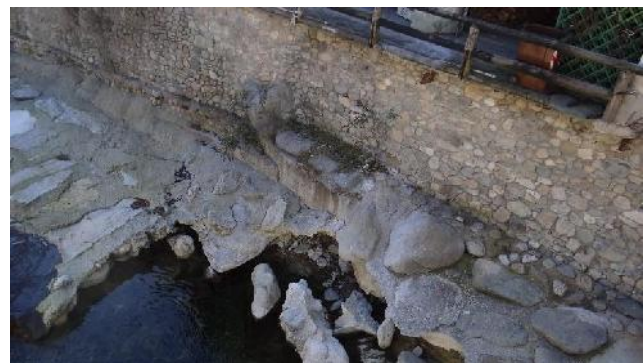
Dettaglio opere a valle della traversa
