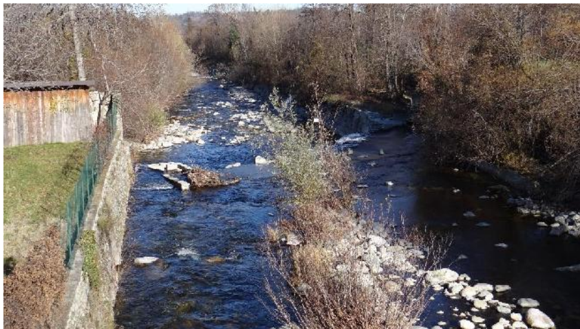
Presa ad uso irriguo a valle dell'abitato di Chiusa Pesio
