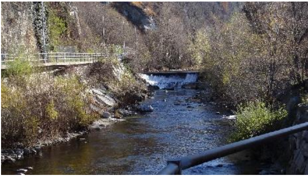
Dettaglio soglia e difese spondali nell'abitato di Chiusa di Pesio
