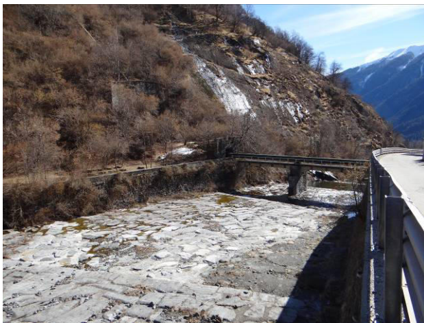
Canalizzazione del fondo alveo nei pressi della centrale di Rovesca
