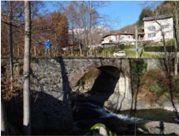
Ponte in loc. Valle , Pralungo
