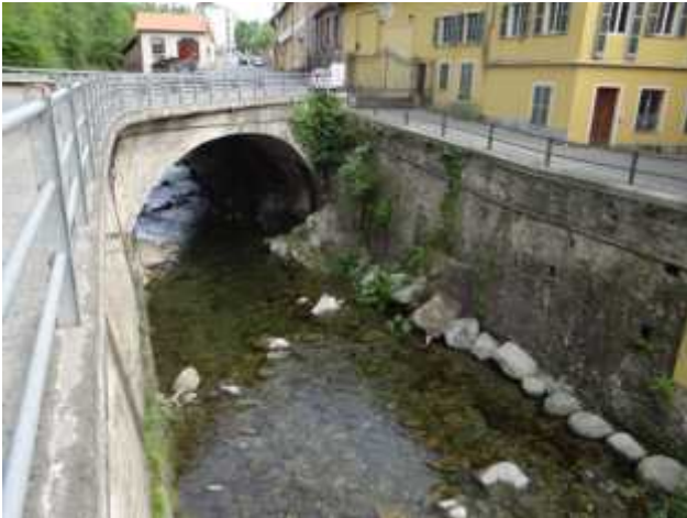
Ponte sul T.Oropa
