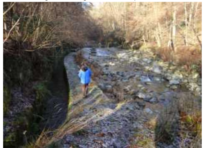
Canale di derivazione della Roggia del Piano
