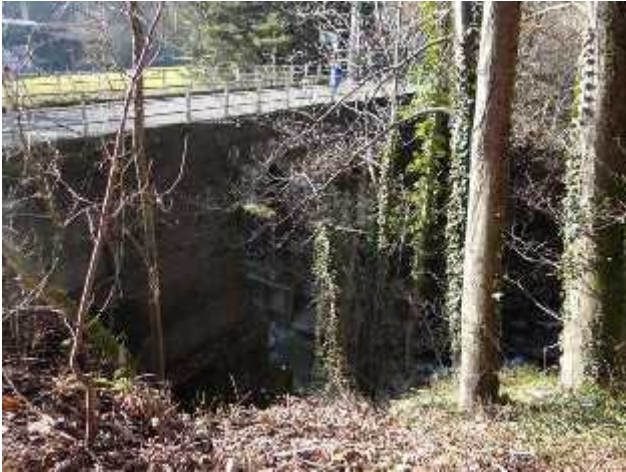
Ponte sul T.Oropa della Str. di Pralungo
