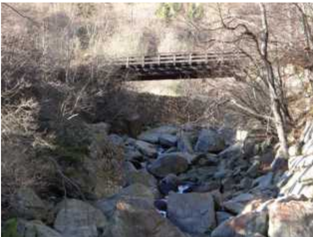
Difese spondali in destra e sinistra
