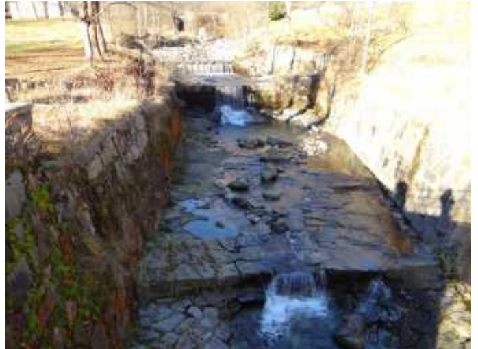
Difese spondali ,rivestimento del fondo e serie di soglie
