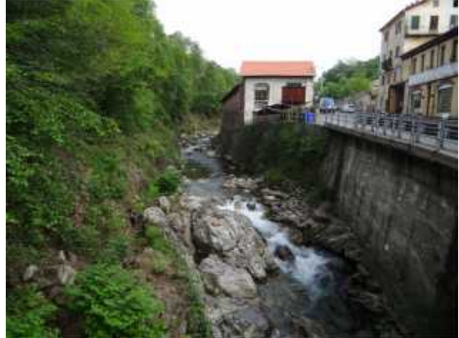
Alveo a monte del ponte
