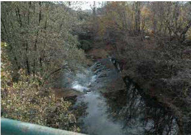
Traversa di derivazione a San Rocco.
