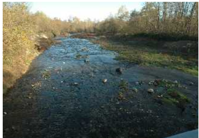
Dal ponte di località Gianotti, difesa in sponda sinistra
