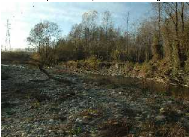
Immediatamente a monte della confluenza del T. Viana, sponda sinistra in erosione
