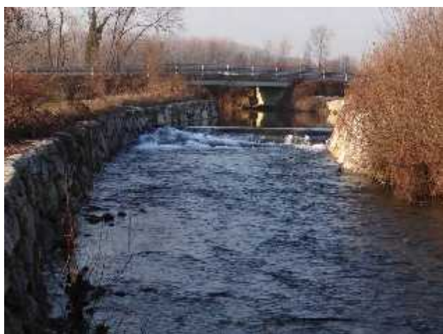
Difesa di sponda e traversa di derivazione presso Ozegna
