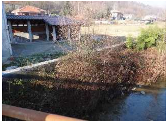
Muro arginale al ponte con Via Ivrea
