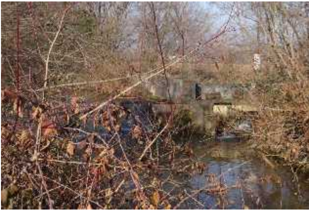
Il Canale Demaniale di Caluso sottopassa il torrente
