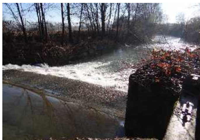
San Giorgio - Traversa per derivazione presso C.na Fogliola
