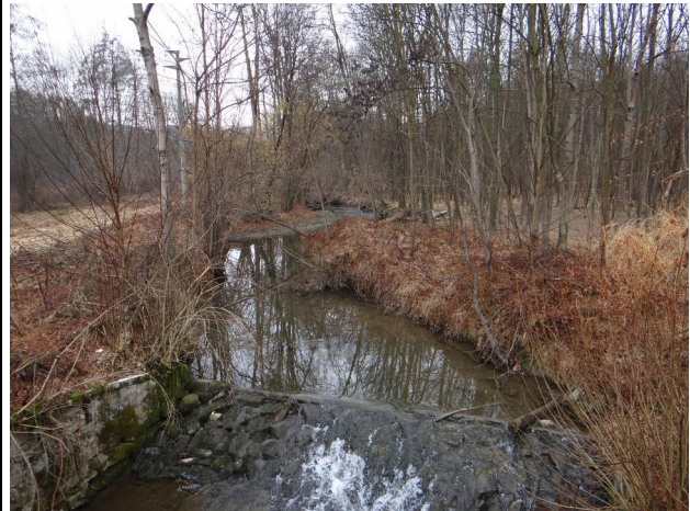
Soglia a monte del ponte della SP 44.
