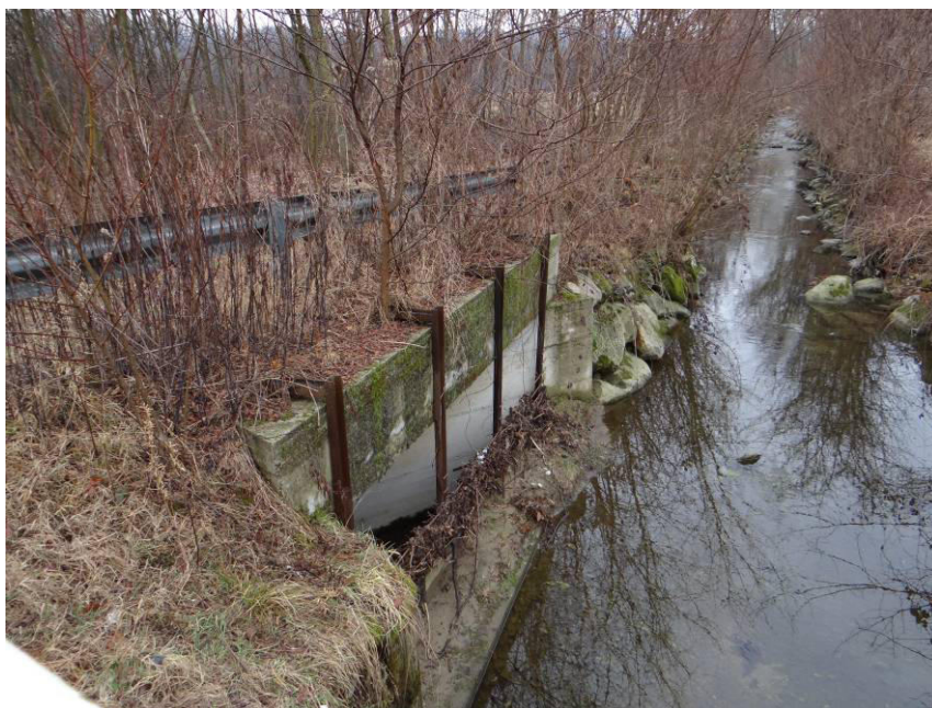
Il canale scolmatore a monte del ponte.
