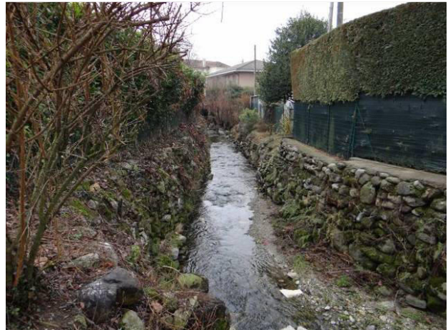
Difese in muretti a secco nei pressi dell'abitato.
