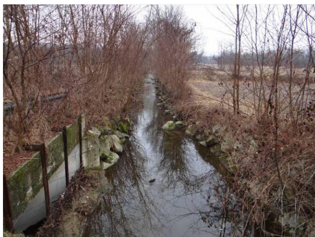
Il canale entro cui scorre il Grua con sponde difese da massi non coesi.
