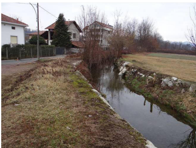
Argine nei pressi del ponte di via Beatrice.
