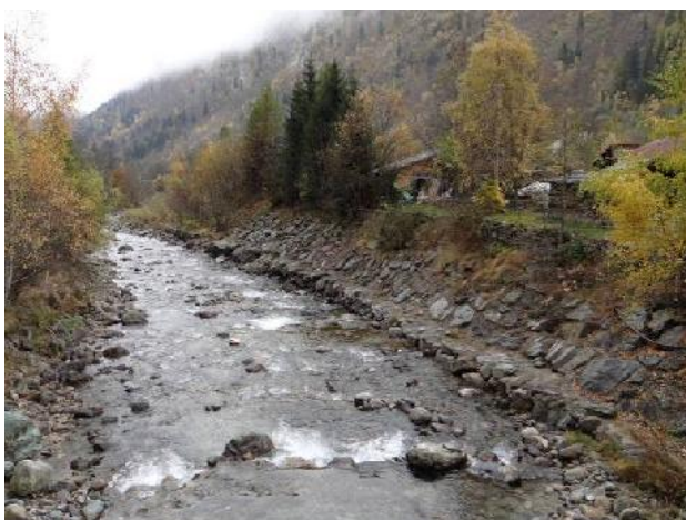
Difesa spondale in destra orografica sottoescavata in più punti subito a monte del campeggio di Alagna.
