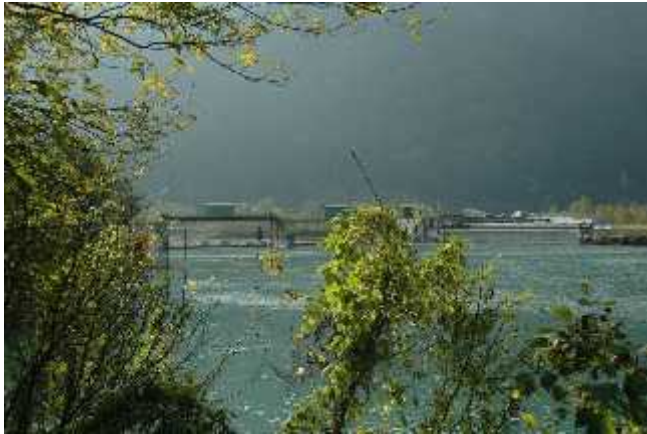
Vista da monte verso valle dell'opera di derivazione in prossimità di Montrestrutto (pressi Loc. castello), all'estremità superiore del tratto.
