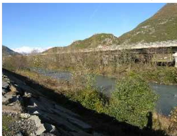
Sant'Antonino, scogliera e viadotto autostradale
