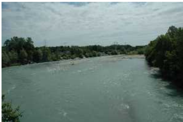
Vista verso valle dal Ponte di Rondissone (inizio del tratto).
