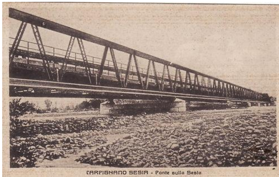
Il ponte stradale in una cartolina d'epoca, l'impalcato è stato recentemente innalzato mentre le pile sono rimaste le stesse.
