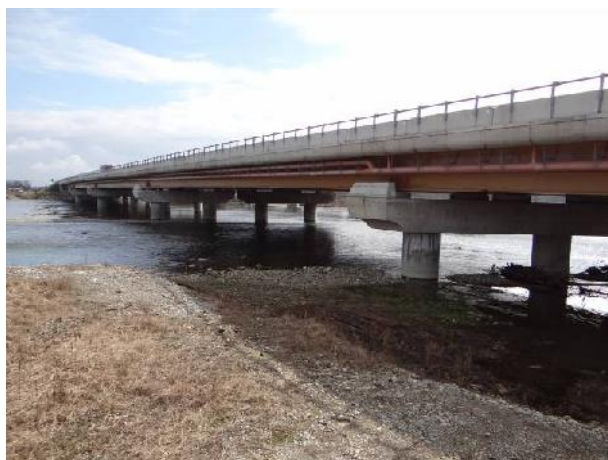
Il nuovo ponte autostradale.
