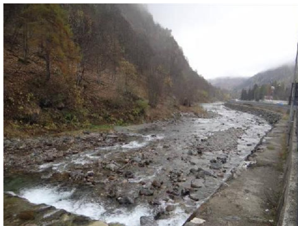
Sponda destra difesa con scogliera di massi cementati.
