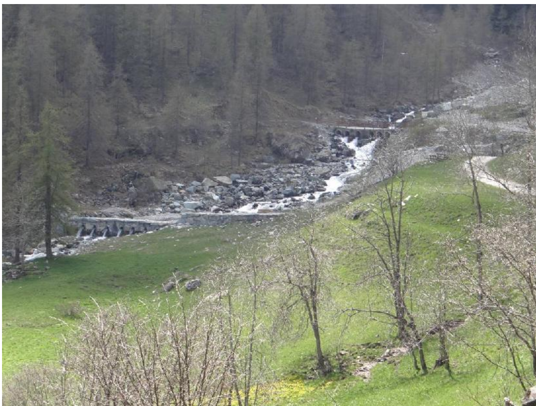
Le briglie in localita Meire Giaromba; quella più a monte funge anche da attraversamento.
