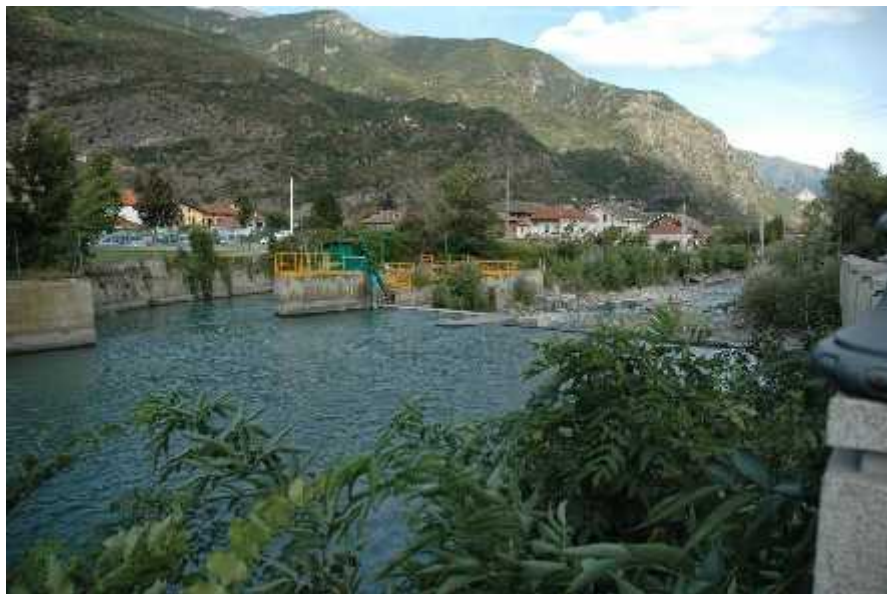
Opera di presa con restituzione nel tratto
