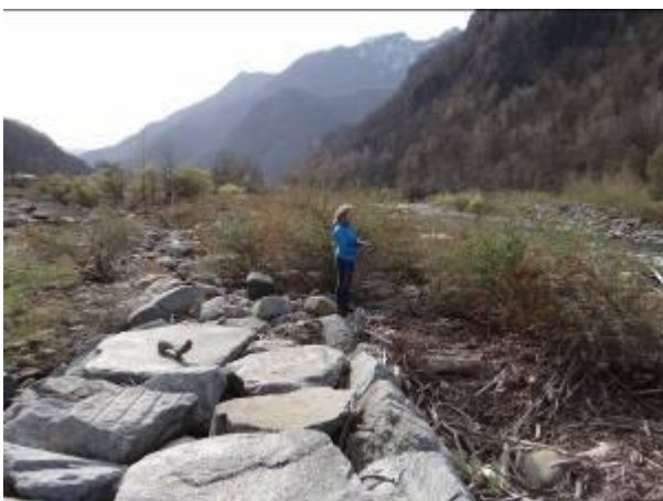
Argine in massi di cava a valle dell'abitato di Vocca.
