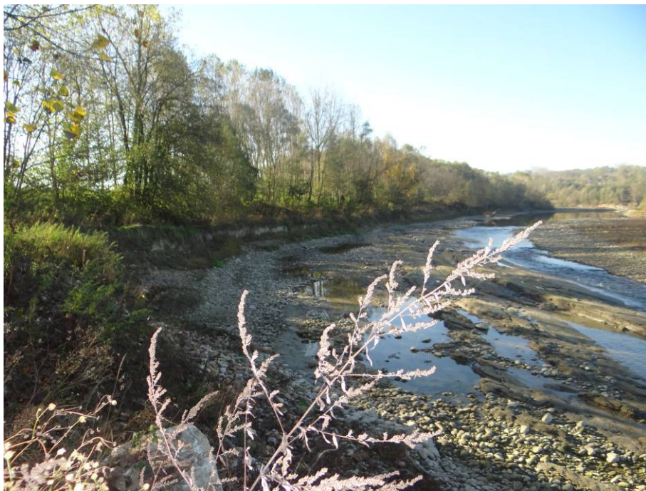
L'alveo in corrispondenza del ponte abbattuto lungo la strada provinciale per Monchiero. E' visibile l'affioramento del substrato roccioso.
