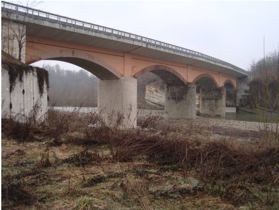
Uno dei ponti della strada di fondovalle con pile in alveo (immagine gentilmente concessa dalla dott. Zerbatò)
