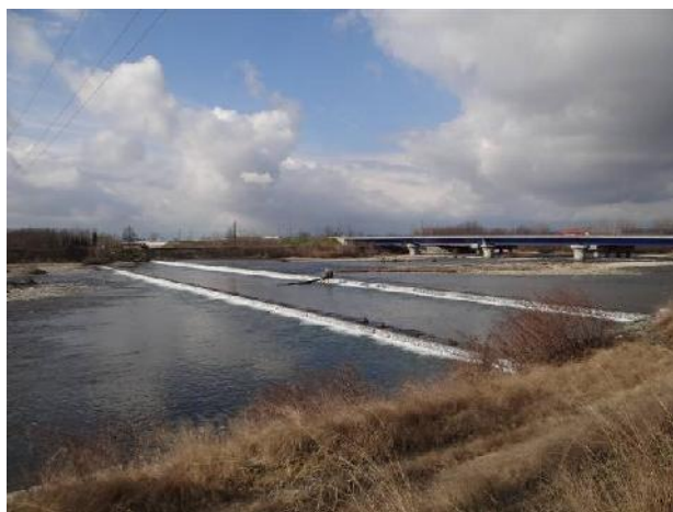
Il canale Cavour e le soglie a protezione dello stesso.
