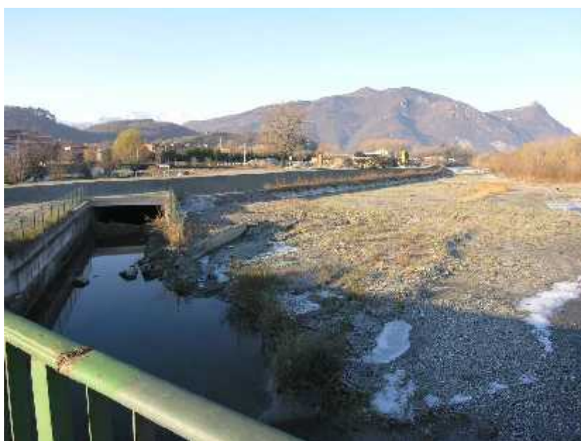
Canale di restituzione a monte del ponte di Via Almese. Argine in sponda destra
