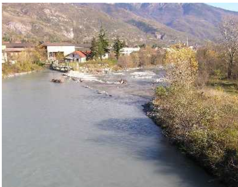
Traversa di derivazione a monte di Bussoleno.
