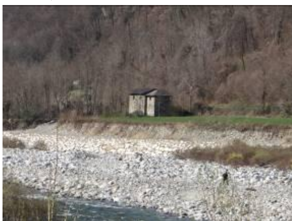
Difese spondali in destra nella parte iniziale del tratto.
