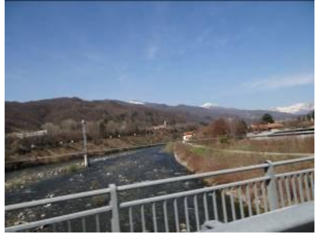
Argine a protezione del quartiere Isola.
