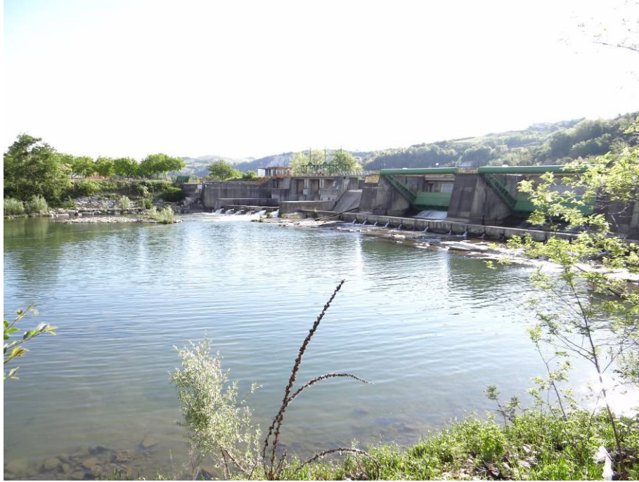
Vista ripresa da valle verso monte della diga dell'ex – Cotonificio di Clavesana
