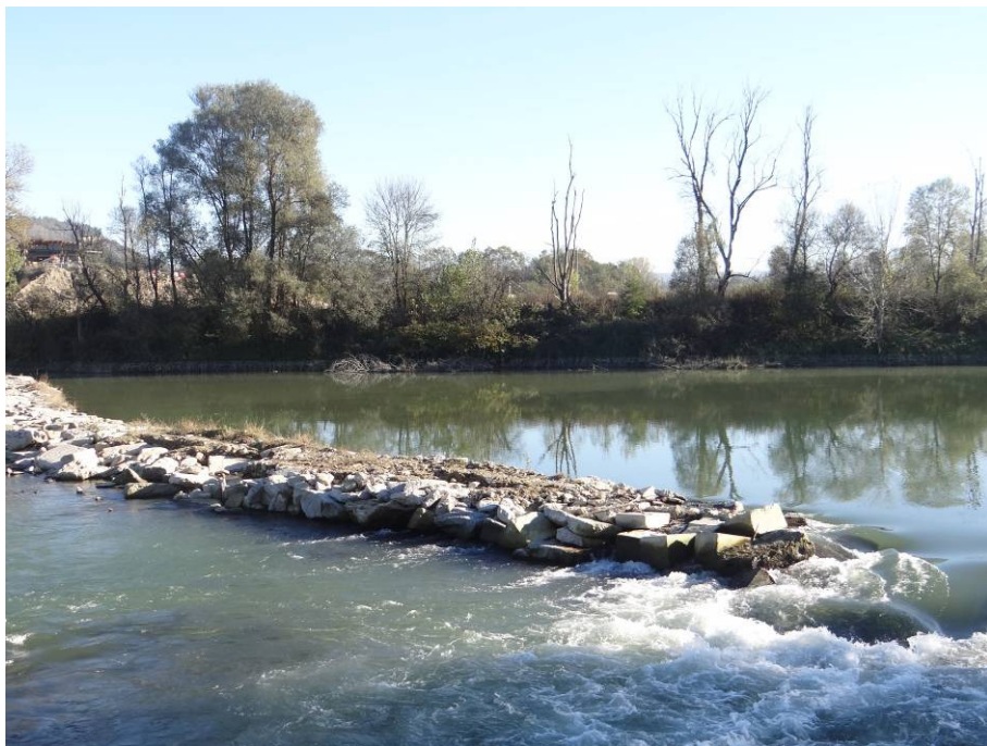
Traversa in massi a servizio dell'area in cava ubicata in sponda destra, poco a valle della confluenza del torrente Mondalavia.
