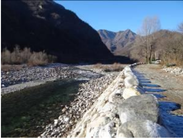
Difese spondali in corrispondenza del campeggio in località Balangera.
