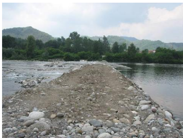
La traversa di derivazione più a monte.
