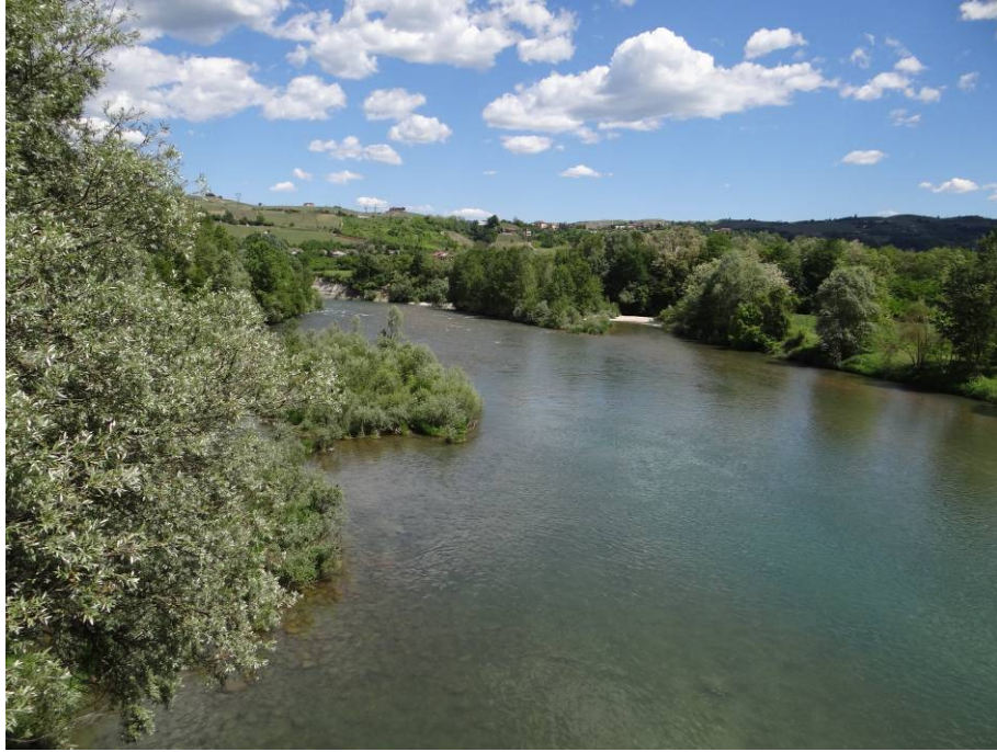
L'alveo in corrispondenza del punto iniziale del tratto.
