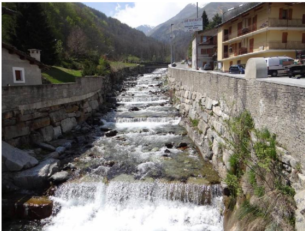
L'alveo ampiamente artificializzato nel centro abitato di Crissolo.
