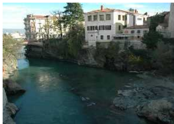
Vista verso valle del F. Dora Baltea e del Ponte Nuovo dal Ponte Vecchio di Ivrea; sponde e fondo alveo in roccia.
