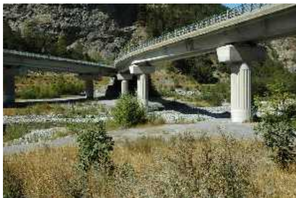
Viadotti autostradali a monte di Oulx
