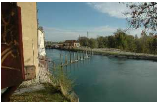
Vista verso monte del Canale Cavour dal Lungo Dora nei pressi di Piazzale Sirio.
