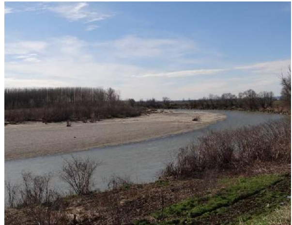
Sulla sponda idr. destra è visibile l'argine con difesa spondale.
