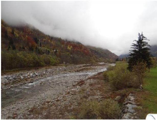
Difese di sponda su entrambe le sponde nel tratto tra il ponte per fraz. Balma e il ponte di Gabbio visibile sullo sfondo (distrutto durante le piene del 1948 e 1977).
