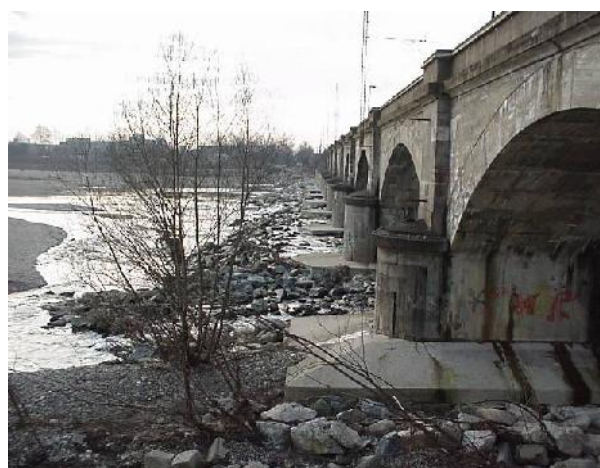
Ponte ferroviario a Vercelli
