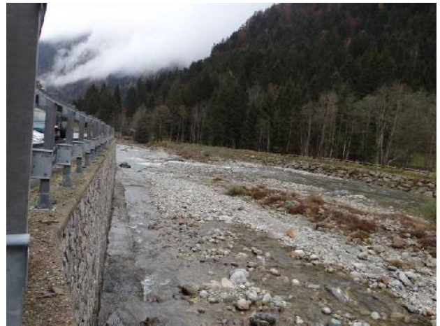
Argine sulla piana alluvionale
