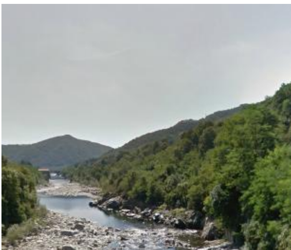
Alveo a valle del ponte di Isolella.
