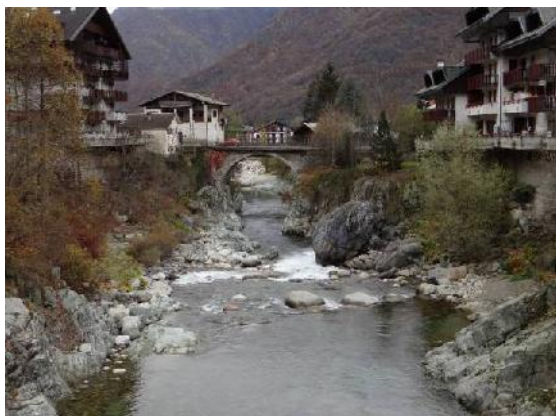
Restringimento dell'alveo in corrispondenza di Scopello
