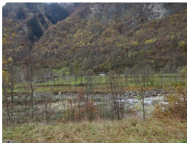
Erosione sponda idrografica destra a sud di loc. Fabbrica.
