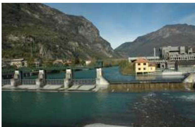
Traversa di derivazione all'estremità inferiore del tratto, in prossimità del ponte di Quincinetto.
