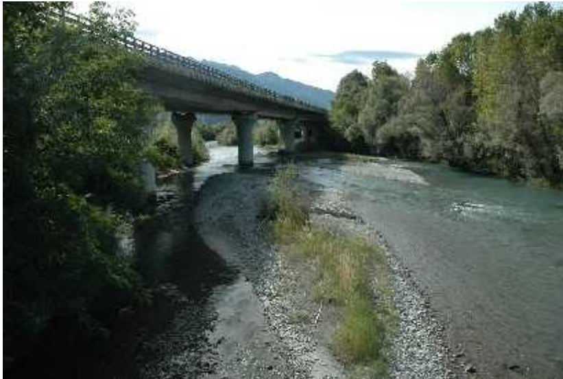
Attraversamento autostradale sulla Dora Riparia visto dal ponte per Condove
