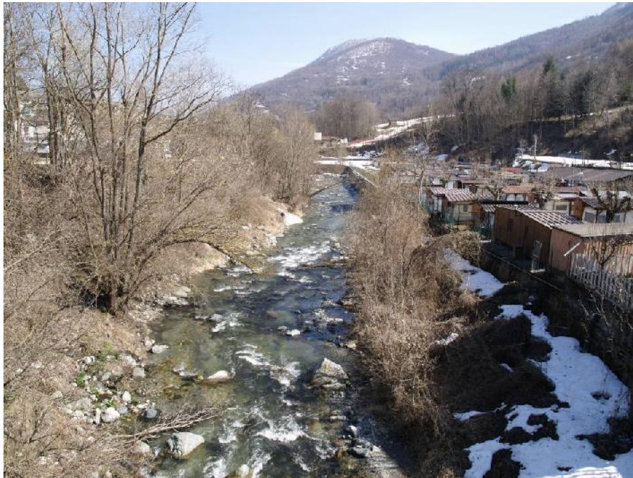
In destra idrografica si osserva il muro a protezione dell'area adibita a campeggio.
