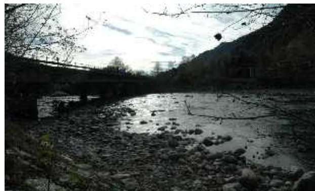
Vista verso valle dell'attraversamento di quota 290 m s.l.m.
