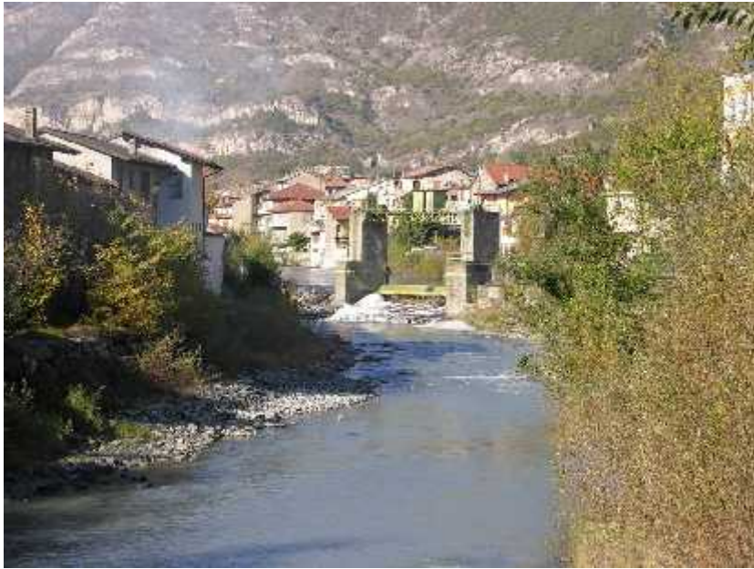
Traversa di derivazione in Bussoleno vista dal ponte Guido Cambursano
