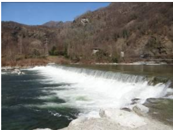
Vista da valle della stessa opera.
