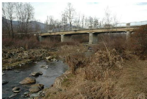
Ponte su Via Susa tra Fiano e La Cassa
