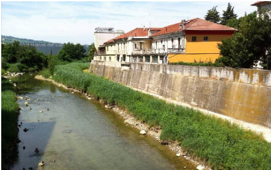
Difese spondali nell'abitato di Canelli
