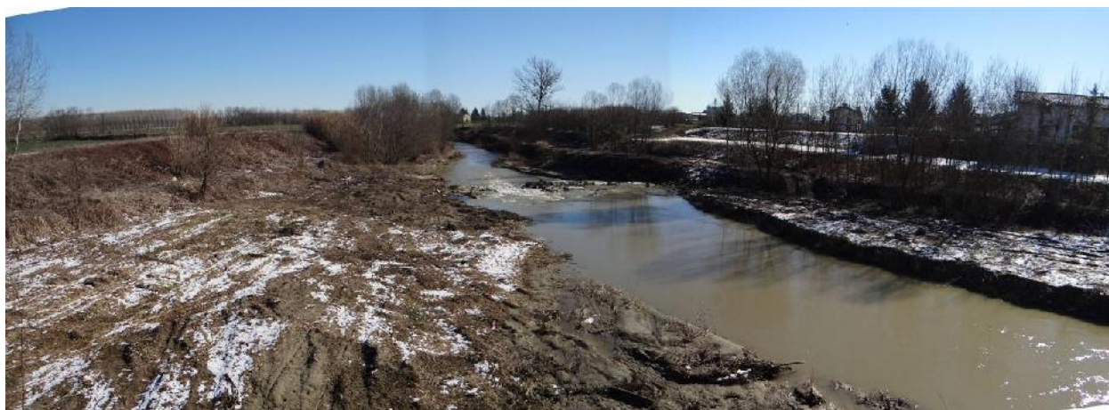
Vista verso valle dell'alveo in corrispondenza del ponte della SP 245.
