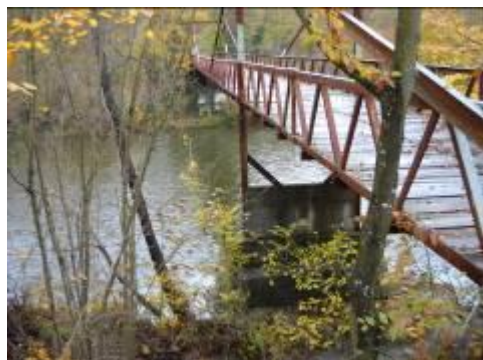
Ponte a monte della confluenza del T. Orbicella.
