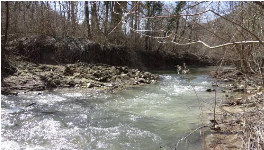
Piccolo deposito in alveo
