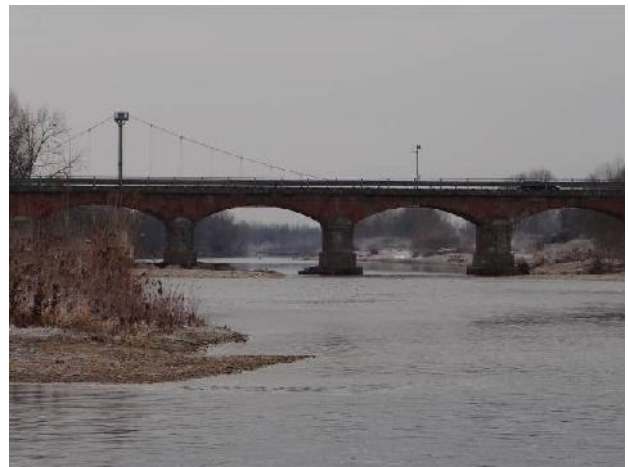
Ponte stradale a Quinto V.se
