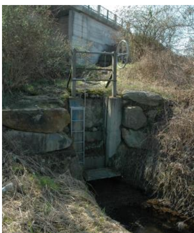
Opera di presa sul T. Orco in corrispondenza del ponte di Feletto.
