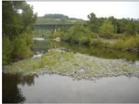
Ponte Ferroviario, Molare
