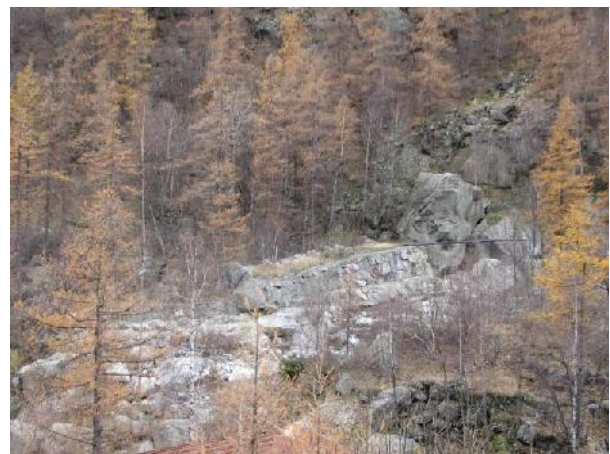
Argine a monte Frazione Gere di Sopra.
