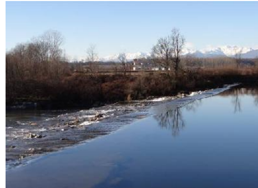
Traversa derivazione a Balocco
