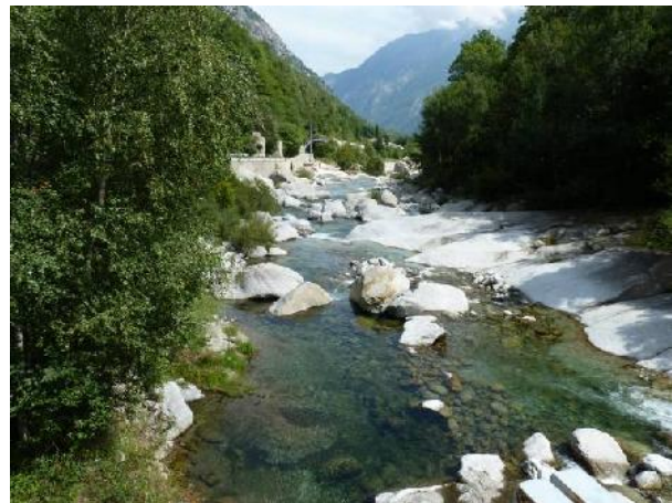
Tratto di alveo in roccia a monte della galleria passante del rio Arianas.
