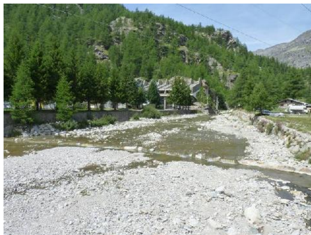
Soglie nella parte terminale del tratto.
