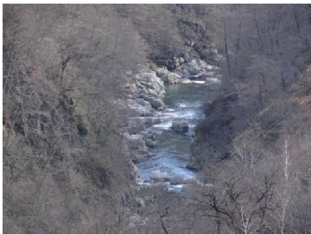
Vista dell'alveo in roccia dalla SP 90.
