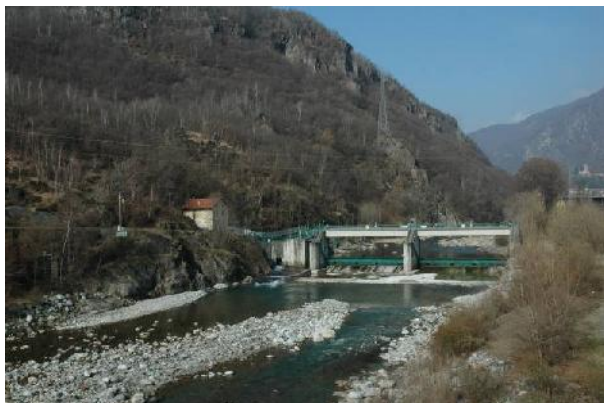
Traversa di derivazione a valle di Pont Canavese.
