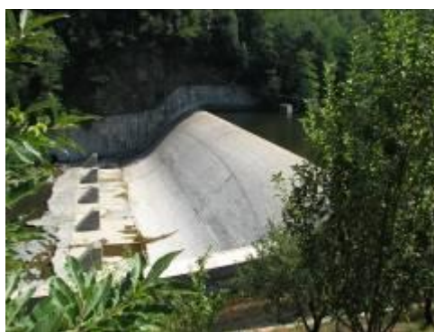
Diga di Ortiglieto, limite di valle del tratto
