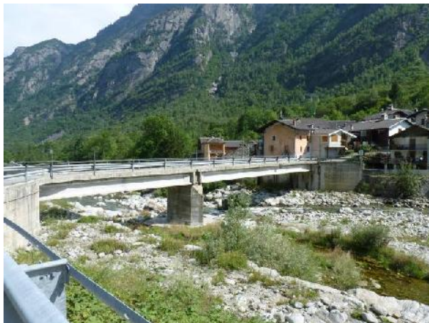
Ponte sul torrente a Borgata Fornetti.
