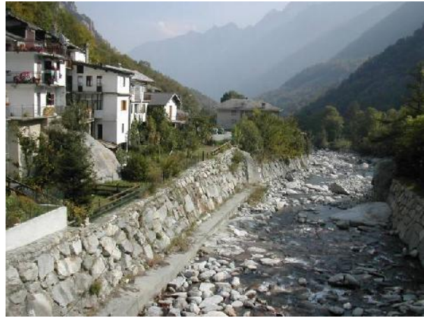
Muro di difesa poco a valle del ponte.
