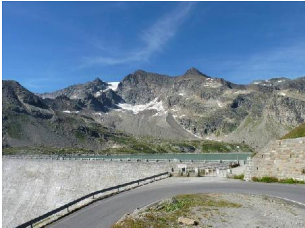
Bacino a monte della diga di Serrù.
