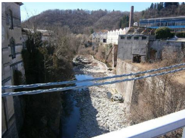
La parte iniziale del tratto dal Ponte Poma a Miagliano
