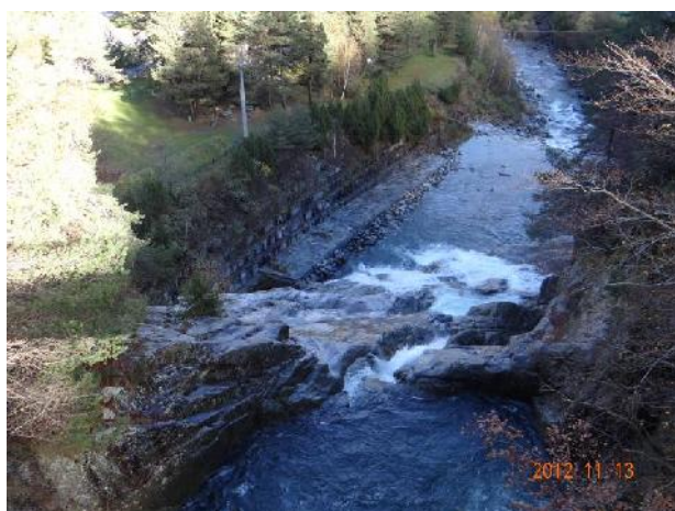
La parte iniziale del tratto 01SS2N282PI_5.
