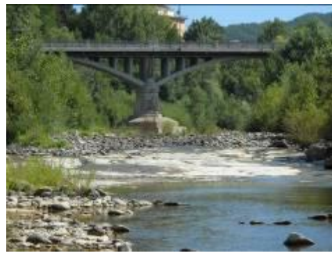
Vista da valle di Ponte S. Paolo, ed affioramento diffuso del substrato
