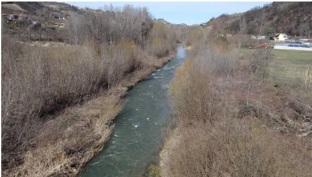
L'alveo a valle del ponte in corrispondenza dell'area industriale di Cossano Belbo
