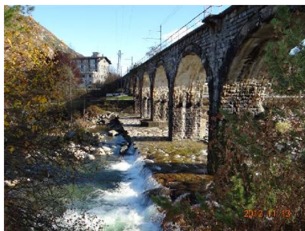
Il ponte della ferrovia nella parte bassa del tratto.
