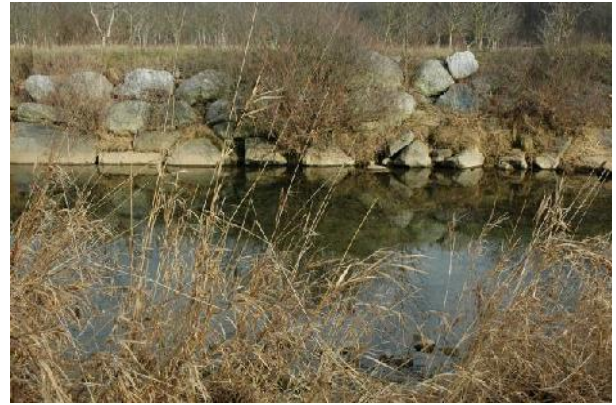
Difesa spondale in massi non cementati in sponda sinistra a valle di C. Bassa di La Cassa
