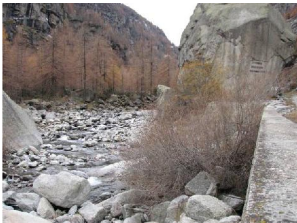
Argine in sponda sinistra a monte di Frazione Pianchette.
