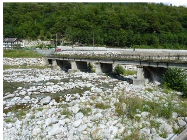
Ponte per la Frazione Reiner.
