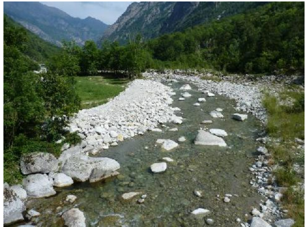
Chiusura di un canale laterale del corso d'acqua in sponda sinistra a valle del ponte apertosi durante l'evento alluvionale del 2000.
