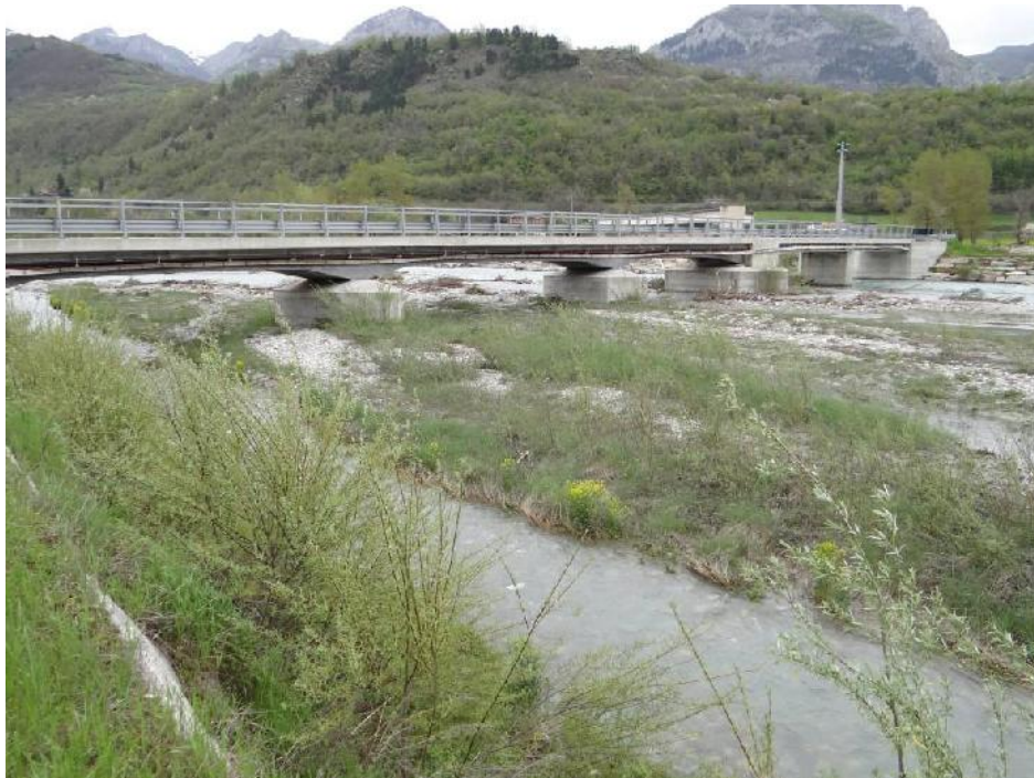
Il ponte ubicato nella parte conclusiva del tratto.
