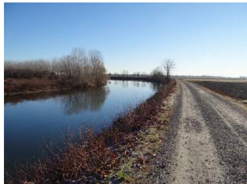
Argine a contatto sponda destra
