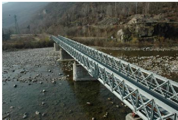
Attraversamento ferroviario a valle di Pont Canavese.
