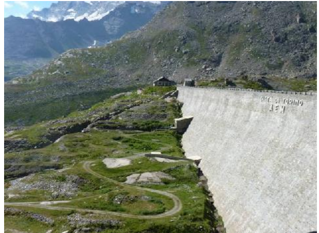
Lo sbarramento in calcestruzzo.
