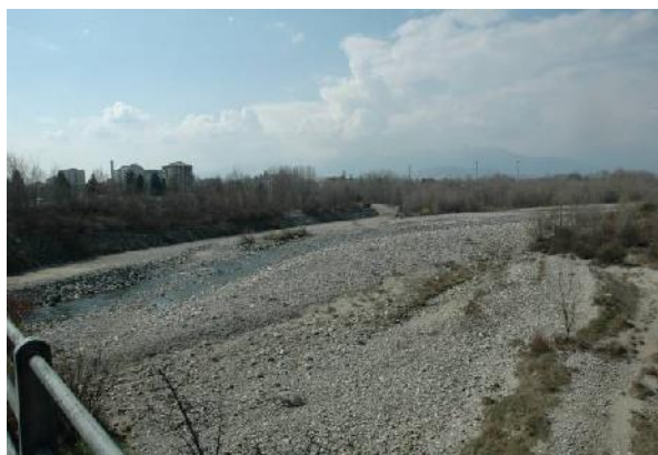
Vista verso monte del T. Orco dal ponte di Rivarolo Canavese. Visibili le importanti difese spondali in destra idrografica a protezione dell'abitato.
