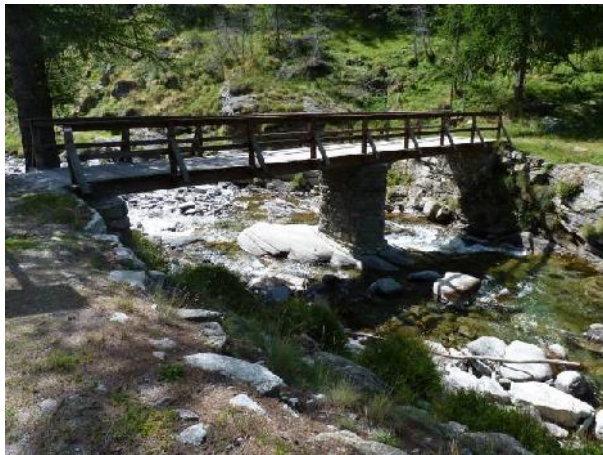
Ponte sul torrente a quota 1679 m.
