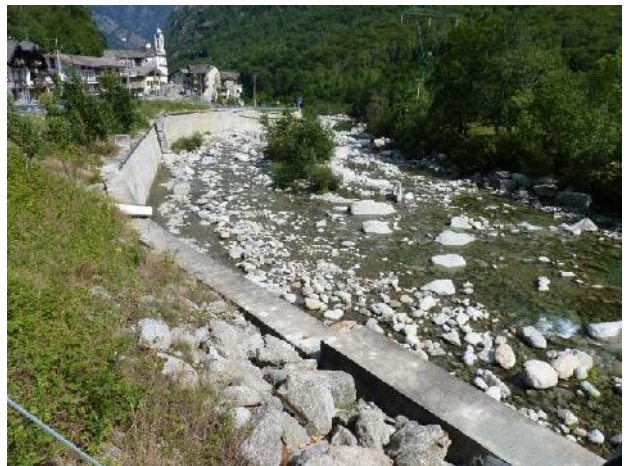
Muro di sponda a Fornolosa.
