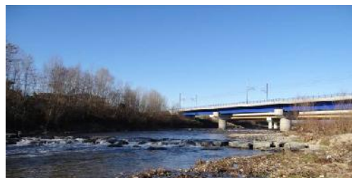
Opere di attraversamento (ponte autostradale e ferroviario) che delimitano l'estremità di monte del tratto
