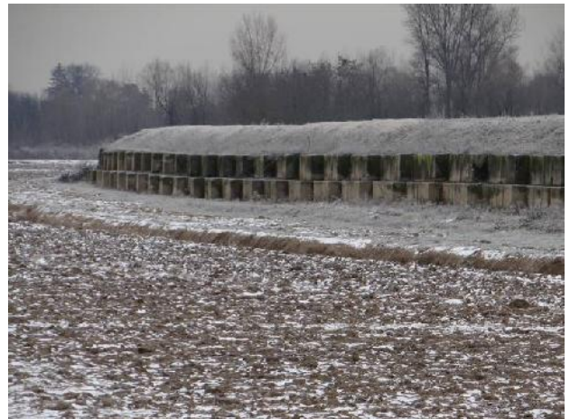
Argine sulla piana alluvionale
