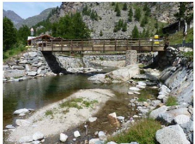
Ponte sul torrente in località Chiapili di sotto.
