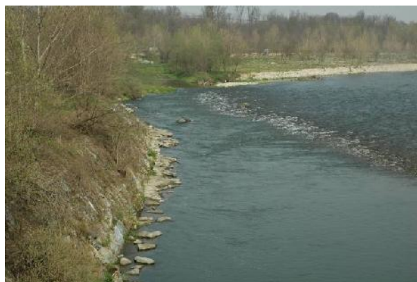
Difese spondali a monte del ponte della SP40 (tra Foglizzo e San Benigno).
