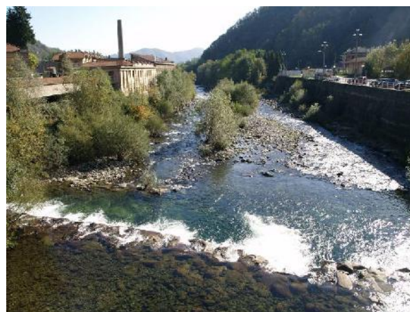
Vista verso valle dal ponte della strada provinciale a Coggiola
