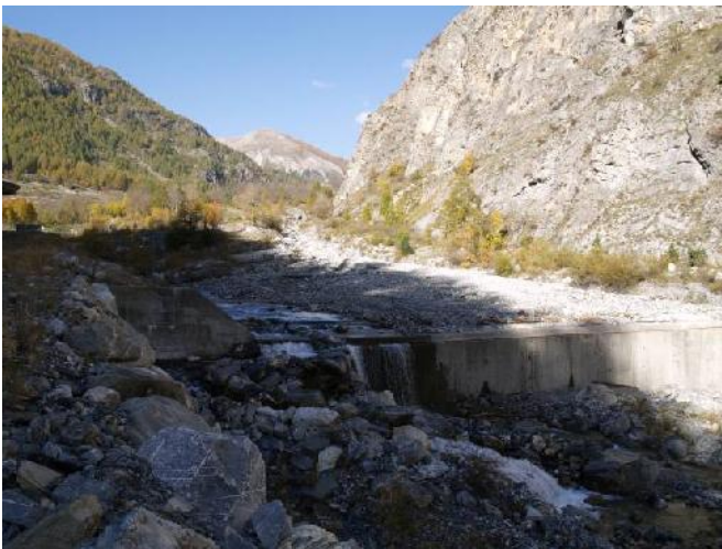
Briglia immediatamente a valle della confluenza, in sinistra idrografica del rio Servagno
