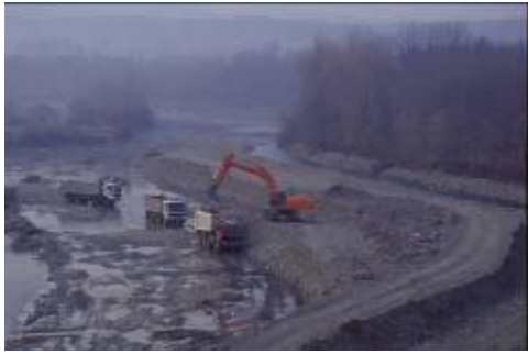
Intervento di rimozione di sedimenti, loc. Cascinotto
