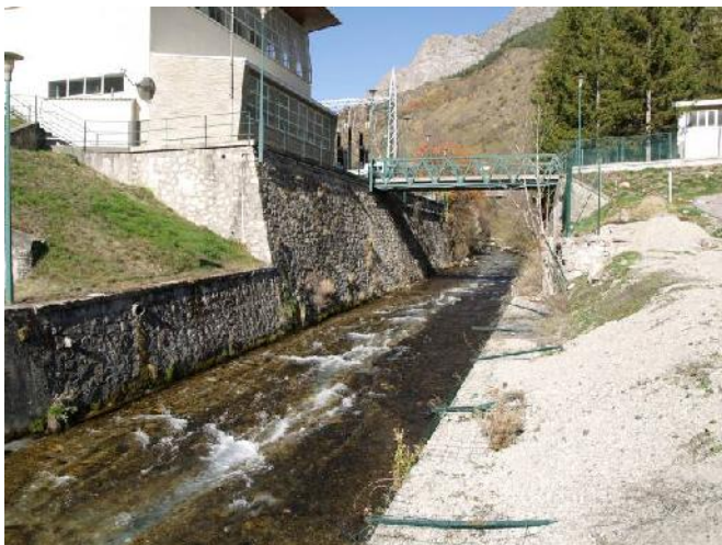
Parte terminale del tratto, in corrispondenza dell'abitato di Pietraporzio, con fondo e sponde completamente rivestiti
