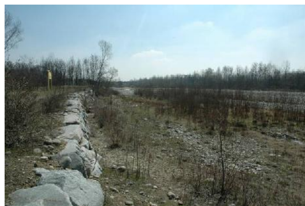
Vista verso monte del T. Orco in prossimità dell'attraversamento del metanodotto di Feletto. Particolare delle difese spondali in destra idrografica.
