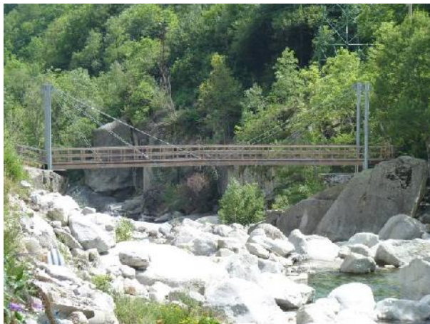
Passerella a valle di frazione Jamonin.
