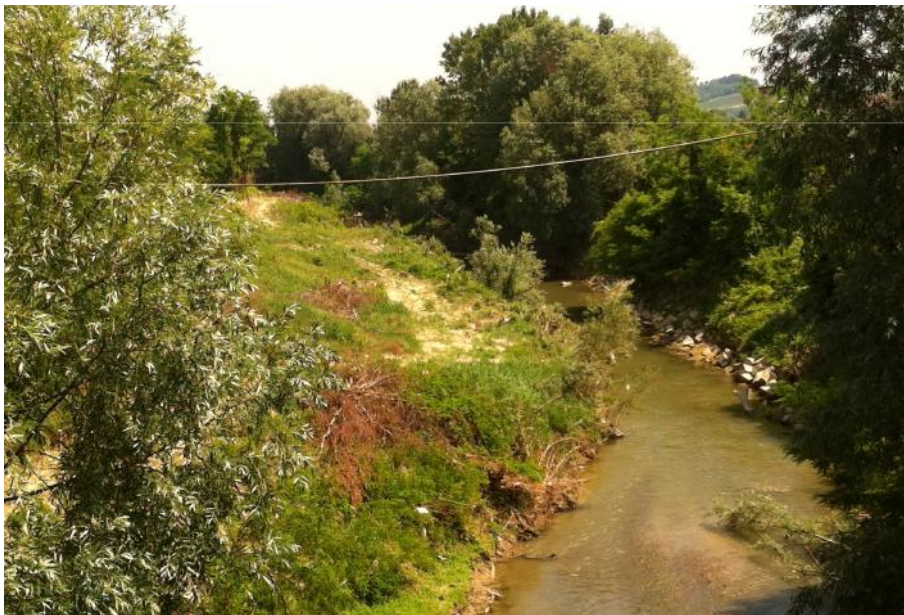
Ripresa verso valle dal ponte di Calamandrana
