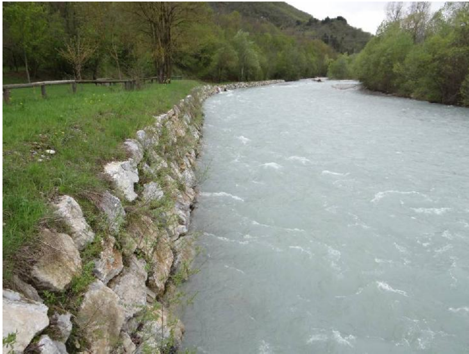
Difesa spondale a monte del ponte di Demonte, poco a valle della confluenza del torrente Cant
