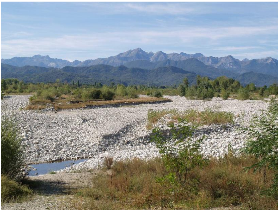
L'alveo immediatamente a monte del ponte Est/Ovest per Cuneo
