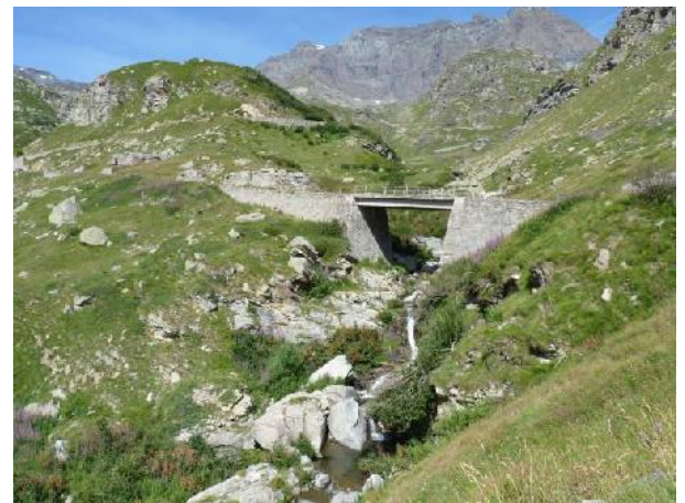
Ponte sul torrente.
