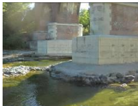
Ovada, ponte ferroviario
