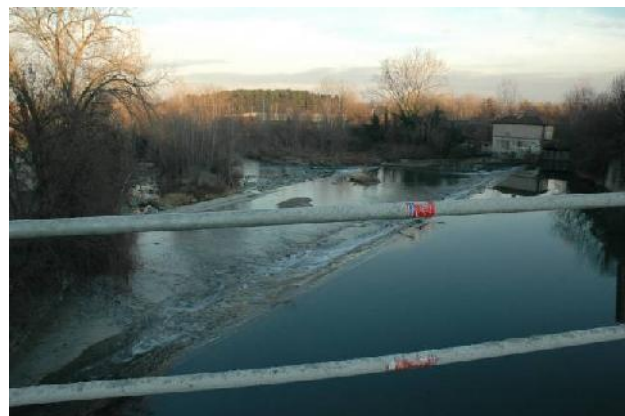
La traversa di derivazione a valle del ponte di Via Cavallo.
