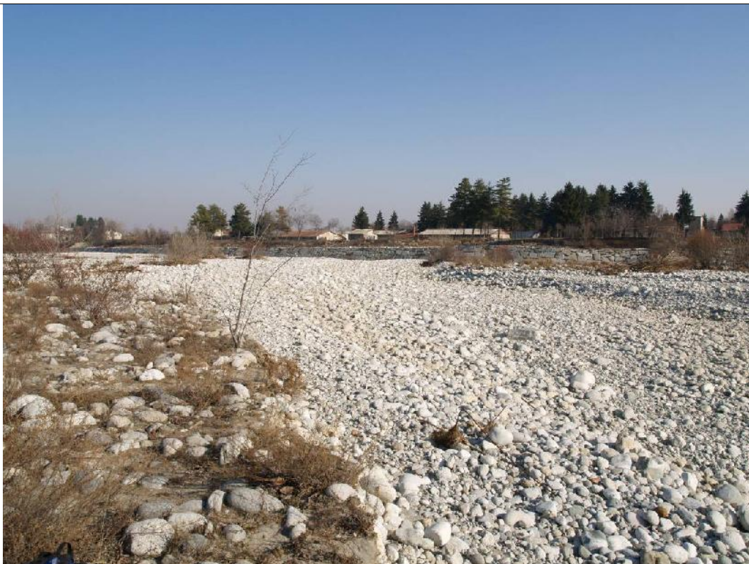
Difesa in sponda destra a protezione di case Nerone
