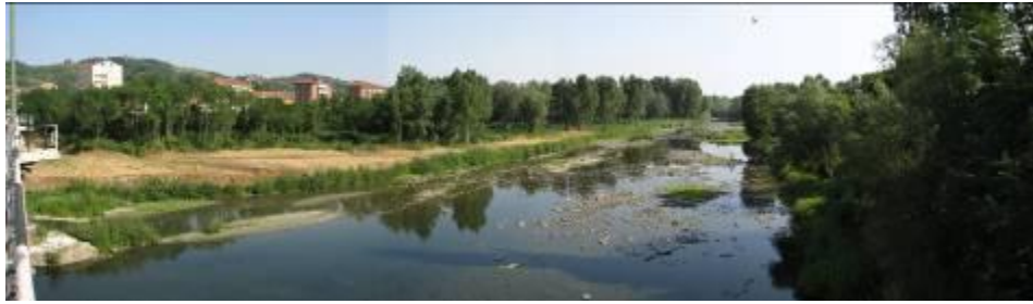
Vista a valle del ponte SP185, si nota in sx una porzione di piana inondabile
