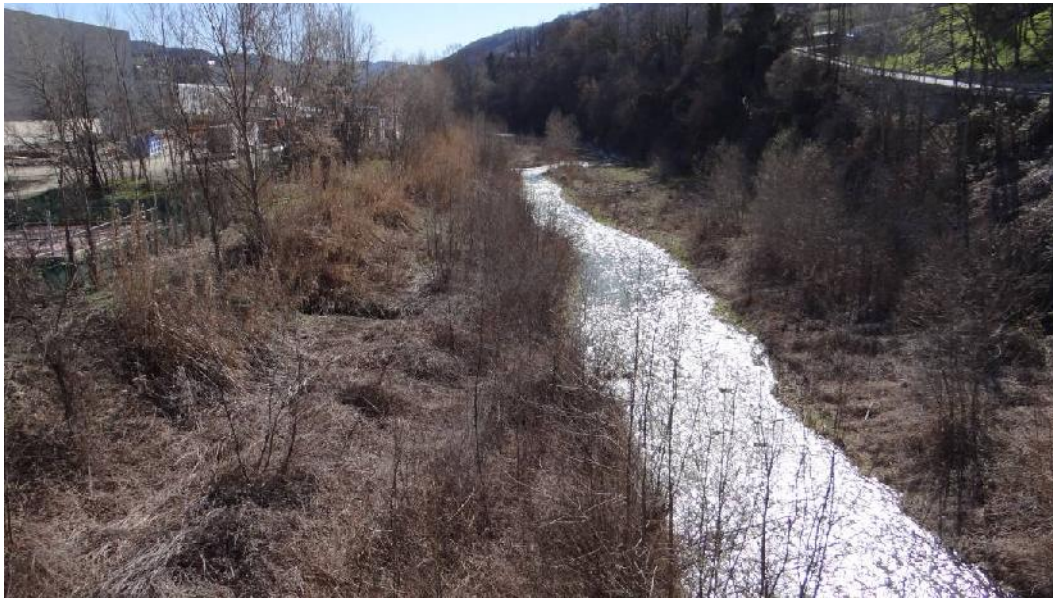
L'alveo a monte del ponte in corrispondenza dell'area industriale di Cossano Belbo
