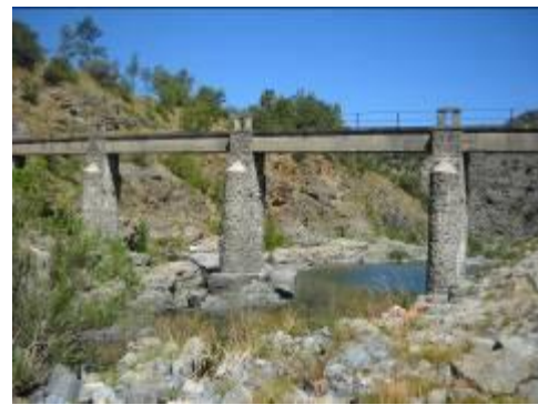
Attraversamento acquedotto in loc. Marciazze
