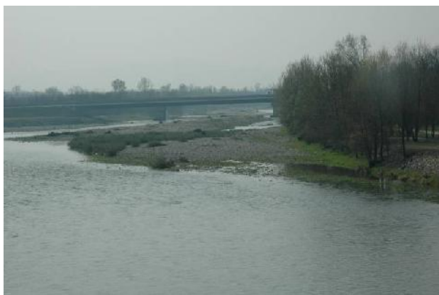
Il T. Orco tra i due attraversamenti (SP40 e A5). Sullo sfondo è visibile il ponte autostradale della Torino-Aosta.
