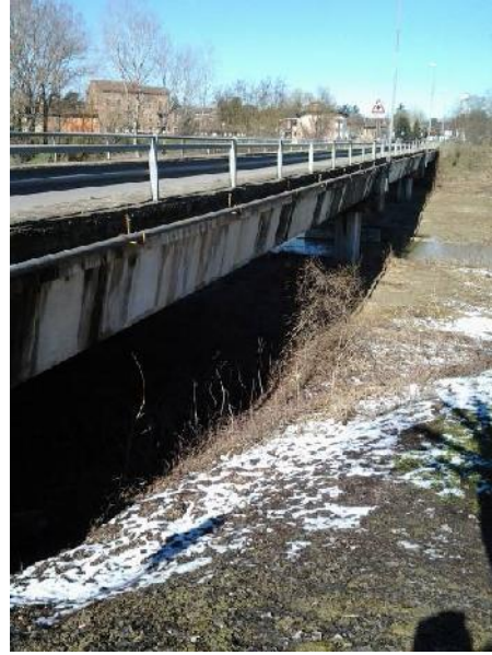
Dettaglio del ponte della SP 245.
