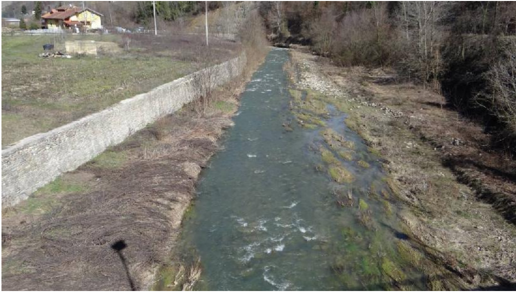
Muro a protezione della sponda sinistra in corrispondenza dell'abitato di Rocchetta Belbo
