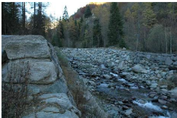
Vista verso monte delle difese spondali (scogliere in massi cementati) in zona di confluenza con il T. Soana.
