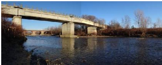
In primo piano l'attraversamento ferroviario, in secondo piano l'attraversamento della SP3.
