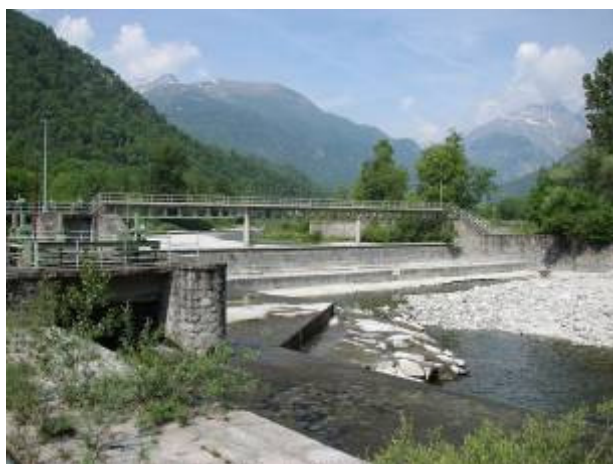
Vista da valle della traversa di Bardonetto.
