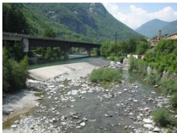
Traversa di derivazione presso l'abitato di Sparone.
