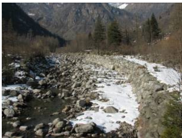
Vista dell'opera di difesa spondale in sinistra idrografica nel settore intermedio del tratto a monte di un attraversamento.
