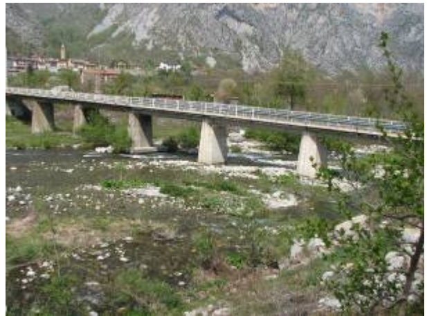
Ponte di Valdieri: le pile in alveo non sembrano condizionare il flusso del materiale solido
