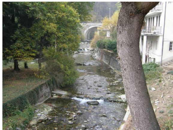
Difese spondali e serie di soglie nella parte a valle dell'abitato di Pradleves.
