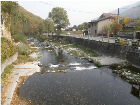
Alveo del torrente nell'abitato di Monterosso Grana. Visibili le difese di sponda e le soglie.
