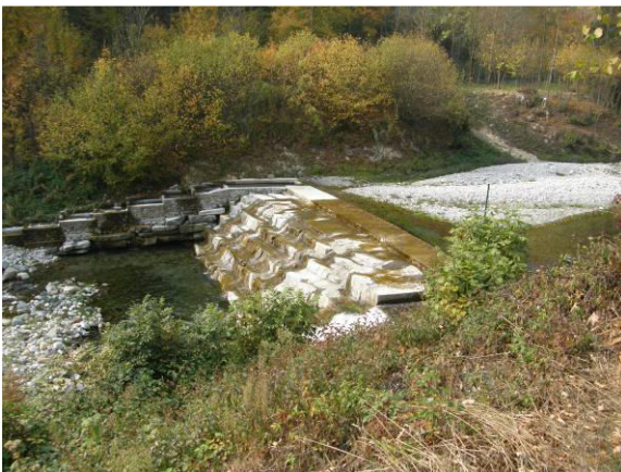
Traversa di derivazione a Pradleves.
