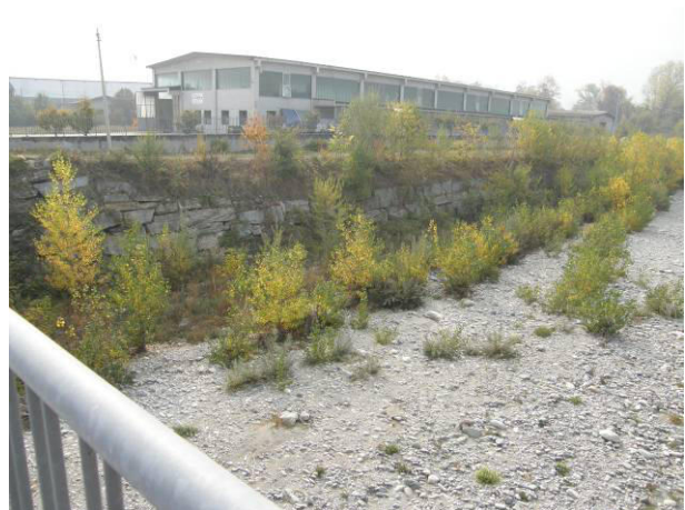
Difese spondali in corrispondenza del ponte della SP210
