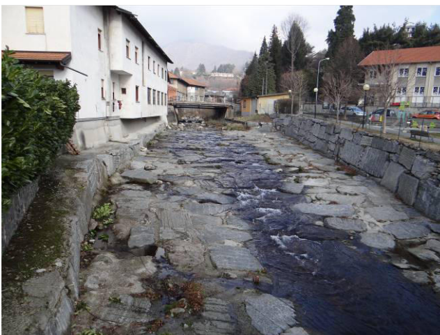
Tratto di alveo canalizzato anche al fondo.
