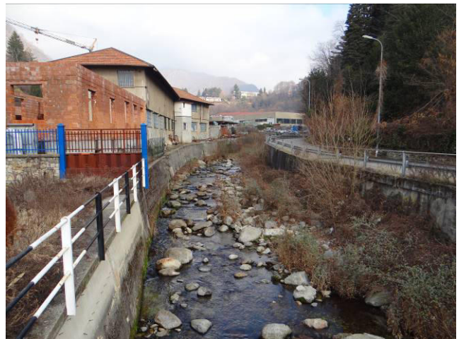
Muri di difesa in calcestruzzo.
