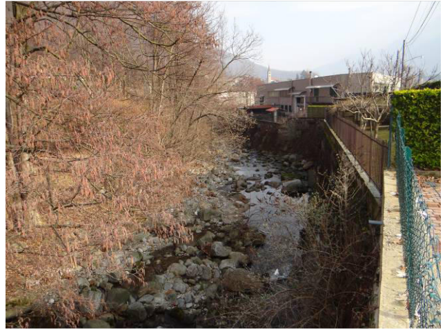
Alveo dal ponte di via Varallo.
