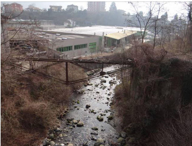
Argini a protezione degli stabilimenti di via delle Brocche.
