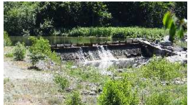
Traversa per prelievo idroelettrico
