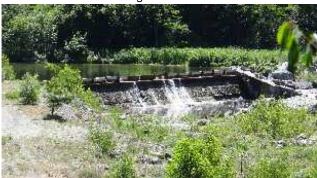
Traversa in chiusura di tratto.
