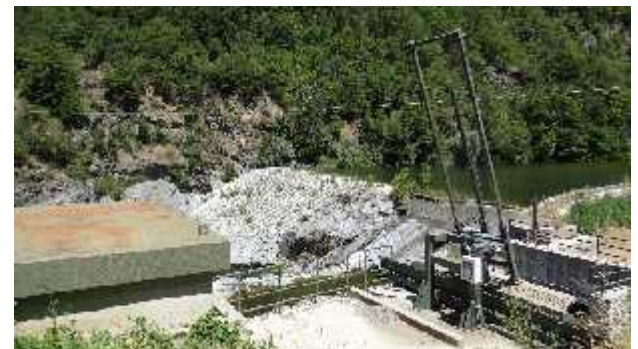
Traversa per prelievo idroelettrico.
