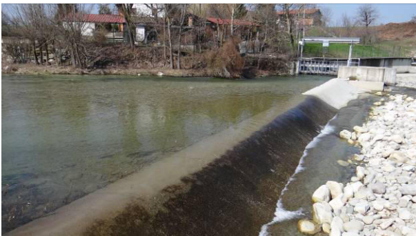
Traversa di derivazione all'inizio del tratto.
