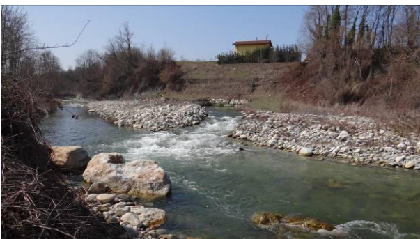
Alveo con restituzione nei pressi di V.la Beila, visto verso monte
