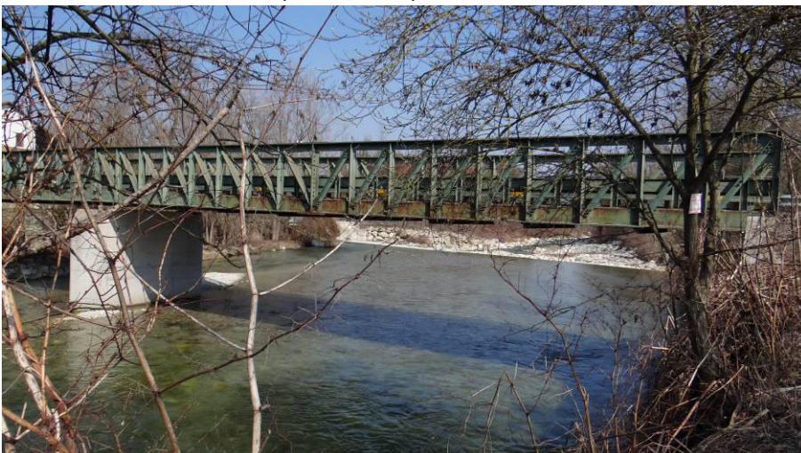
Ponte di Strada al Molino Lavagna con pila in alveo alla fine del tratto
