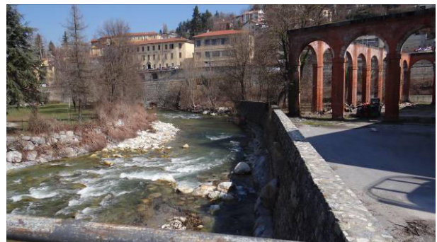
Difese di sponda viste dal ponte di Via Curazza
