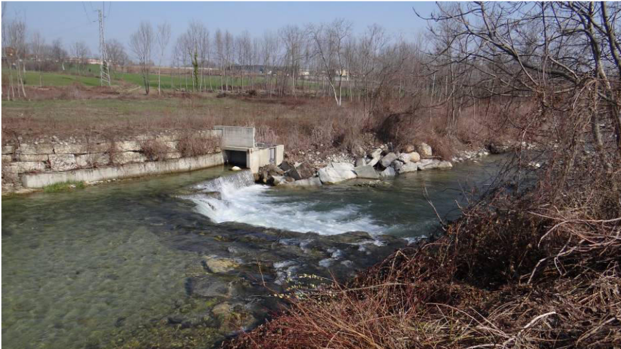
Traversa di derivazione all'inizio del tratto
