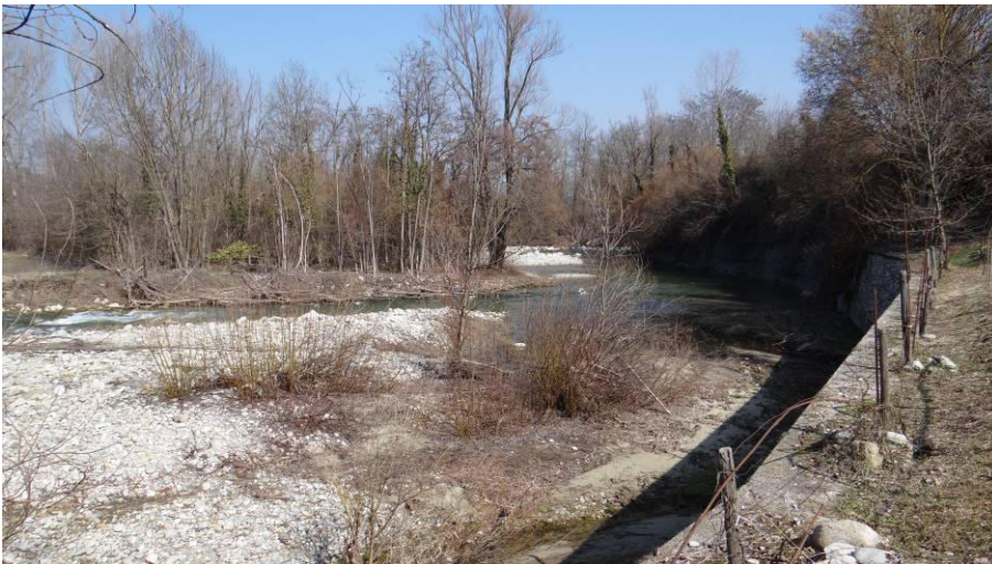
Alveo con sponda difesa presso Comini di Ellero
