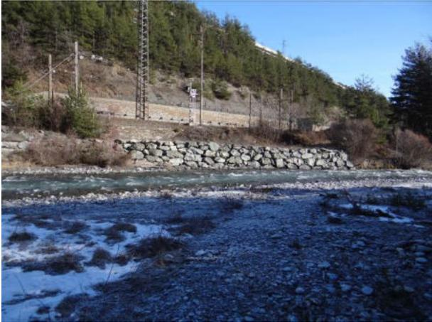
Alveo a monte di Beaulard. Difesa in blocchi in sponda sinistra, dietro la quale è visibile il rilevato ferroviario
