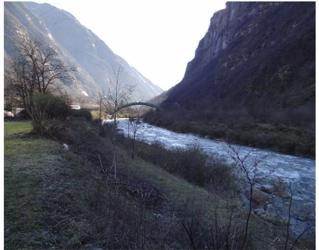
In primo piano, in sinistra idrografica, la difesa spondale e in secondo piano il sifone di attraversamento del canale di derivazione del t. Diveria che convoglia le acque sino alla centrale di Crevoladossola.
