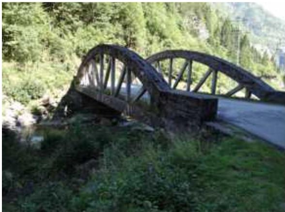
Ponte interferente con onda di piena
