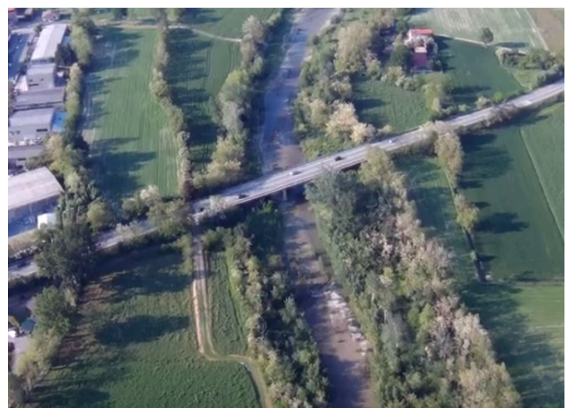
Ponte della SPexSS10 con pile interferenti.
