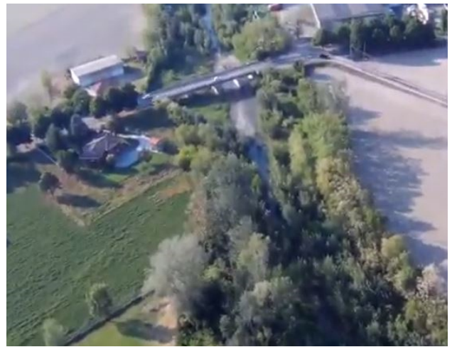
Ponte di Viale Gramsci.
