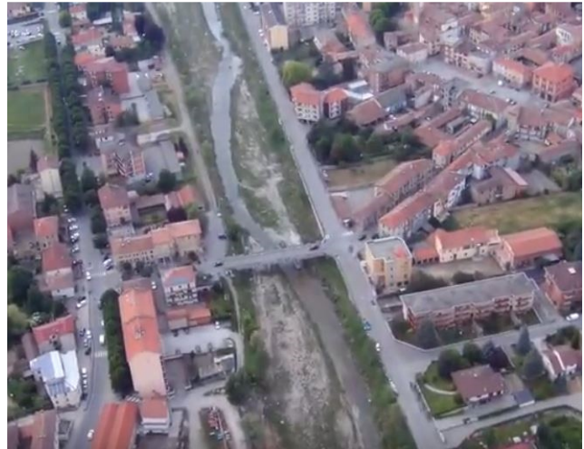
Alveo rettilineo, con sezione omogenea, nell'attraversamento dell'abitato di Volpedo.
