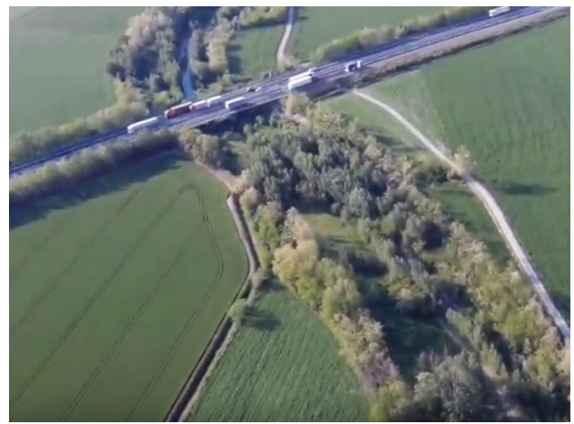
Ponte della A21
