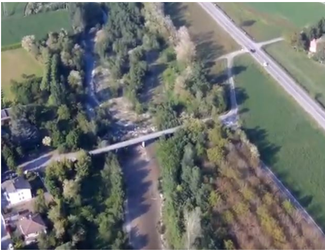
Ponte di Viale Di Vittorio con soglia a valle.
