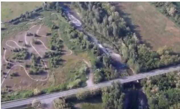
Ponte della SP99 e soglia a valle.
