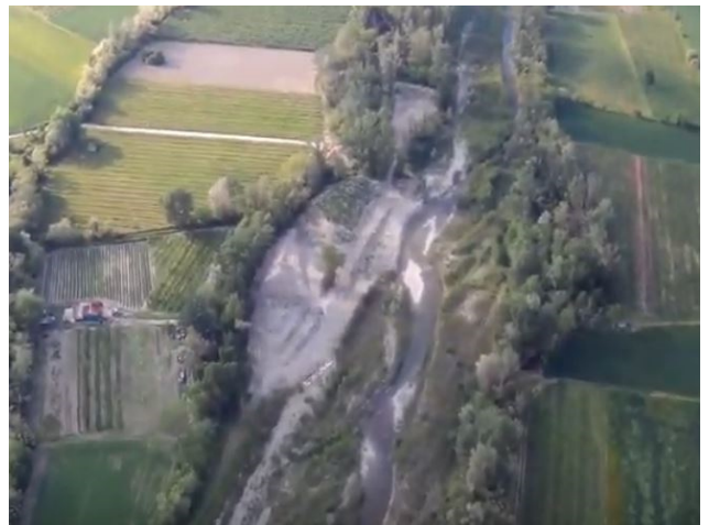
Risagomatura della sezione dell'alveo con rimodellamento della sponda sinistra in corrispondenza di C.na Fontana.
