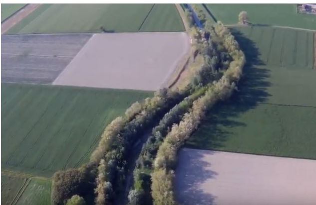
Parte terminale del tratto con argini a contatto
