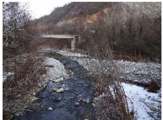
Confluenza con il torrente Casotto.
