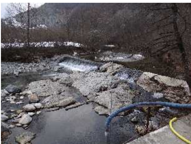
Traversa in corrispondenza di un prelievo.
