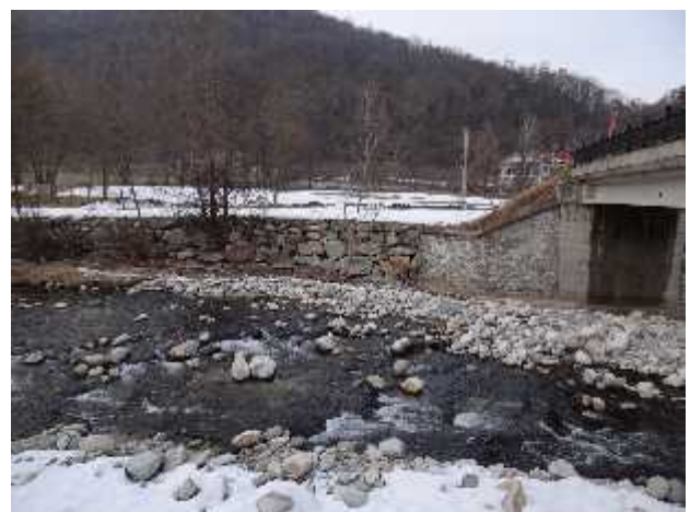
Particolare di un attraversamento stradale.
