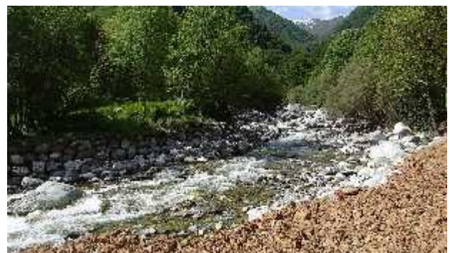
Difese spondali in sponda destra.
