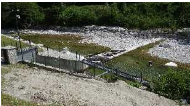
Impianto di derivazione idroelettrica.
