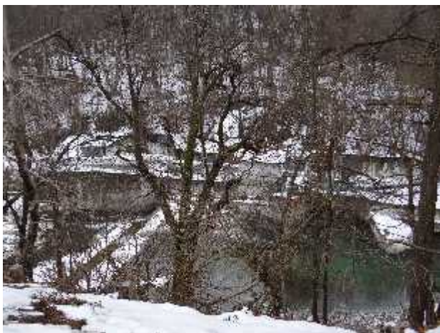
Impianto di derivazione idroelettrica.
