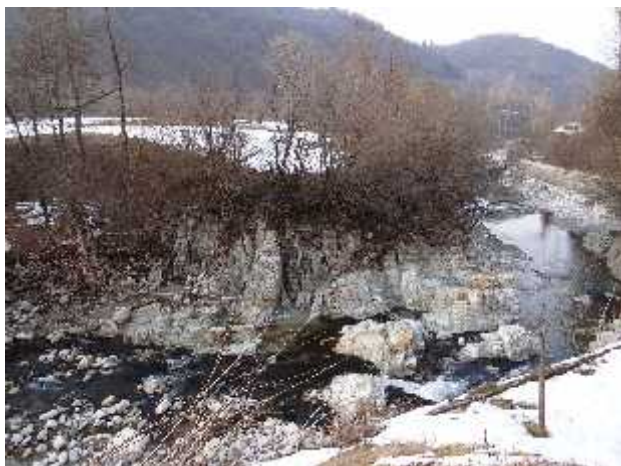
Dettaglio dell'alveo e delle sponde.
