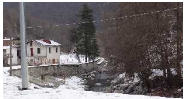
Arginatura in sponda sinistra.
