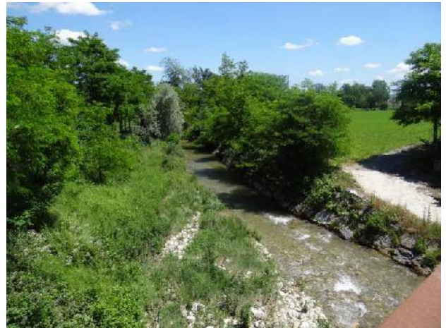
Alveo visto dal Ponte della SP564 a Beinette. Difese di sponda in corrispondenza del ponte.
