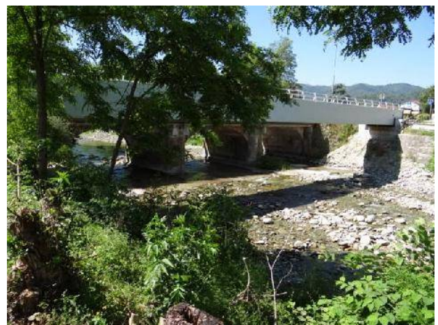
Ponte della SP21 a Boves
