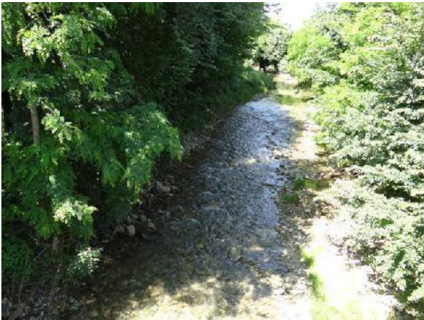
Alveo visto dal ponte della SP5 per S. Lorenzo, con corazzamento del fondo.
