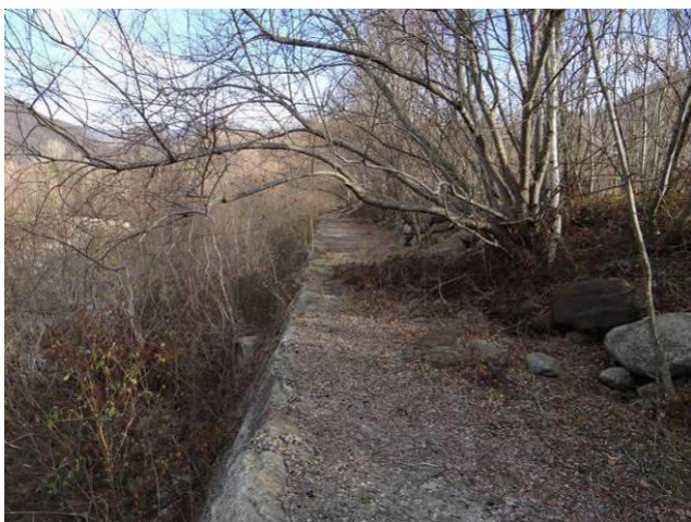
Argine in sponda sinistra.
