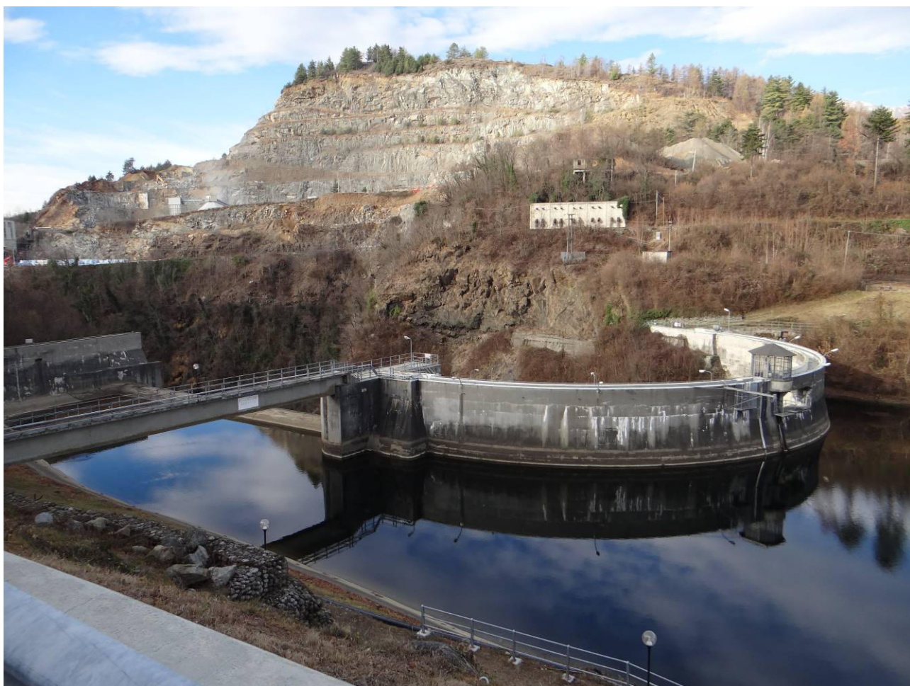
Coronamento della diga Gurzia.
