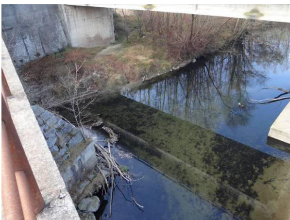
Particolare del fondo alveo.
