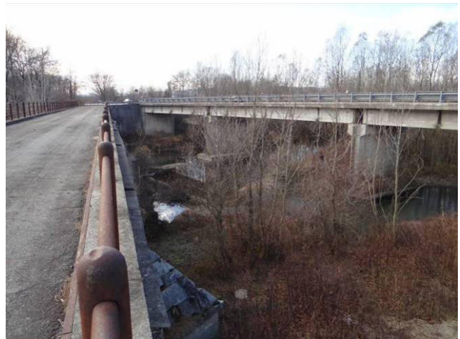
Le pile del ponte della SP 77.
