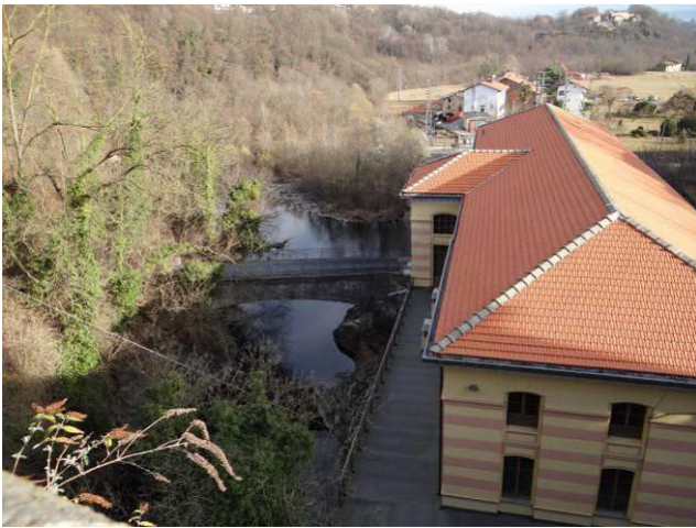
Parte iniziale del tratto.
