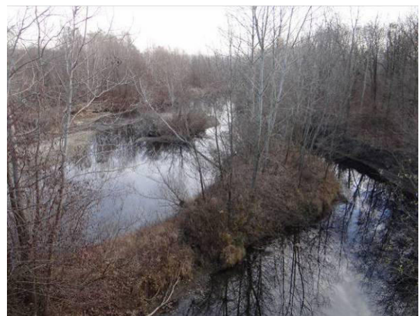
Alveo a valle del ponte.
