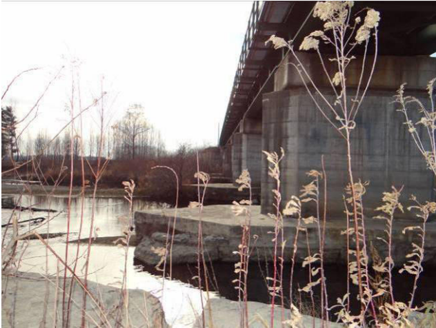
Ponte ferroviario della linea Ivrea -Torino.
