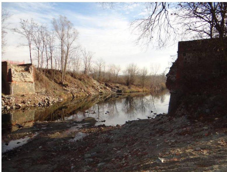
Spalle del vecchio ponte di via Maioletto.
