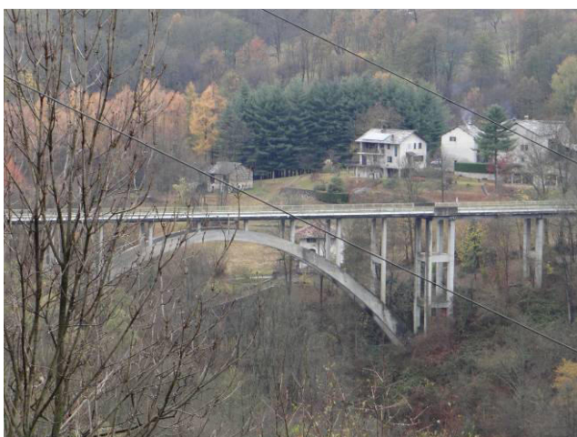
Il viadotto tra Rueglie e Alice Superiore.
