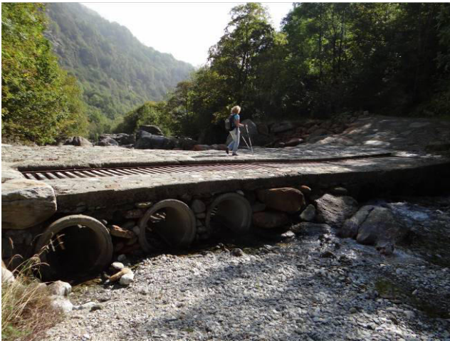
Il guado nell'estremità a monte del tratto.
