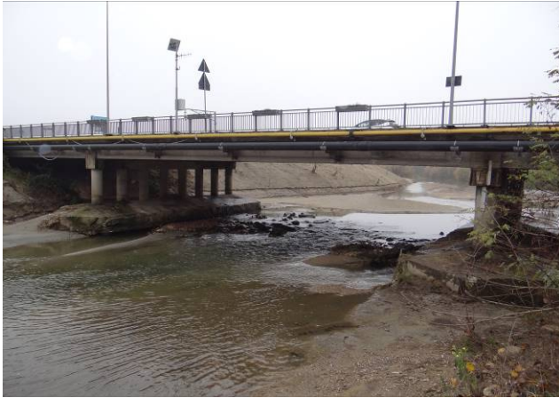
Vinovo: ponte della SP143
