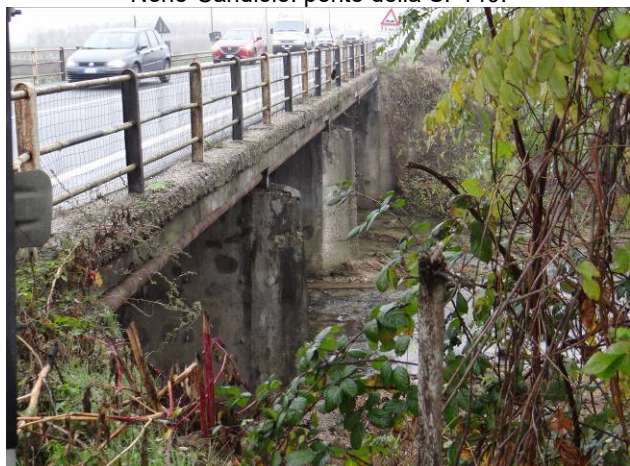
Piobesi Torinese: ponte della SP142.
