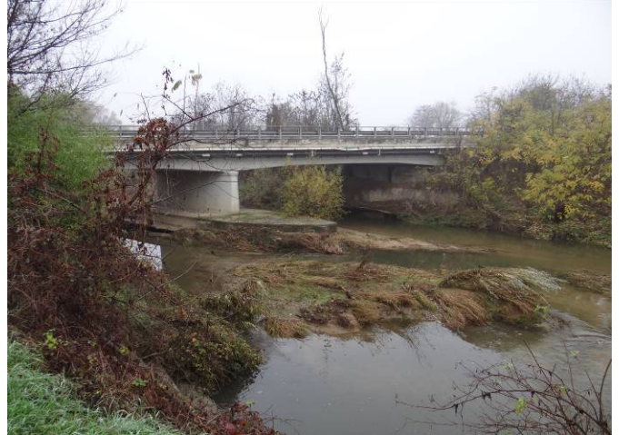
None: ponte della SP23R
