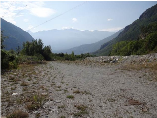
Novalesa: argini in corrispondenza della confluenza con Torrente Marderello
