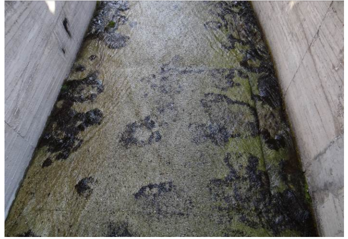
Dettaglio della lastricatura del fondo.
