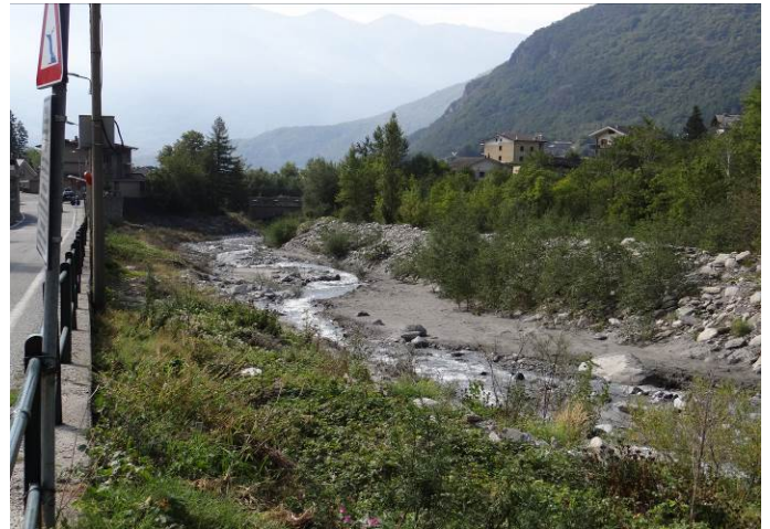
Novalesa: argini in corrispondenza della confluenza con Torrente Claretto.
