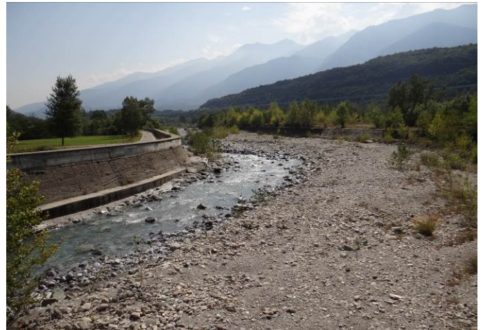
Venaus: argini lungo la strada comunale.
