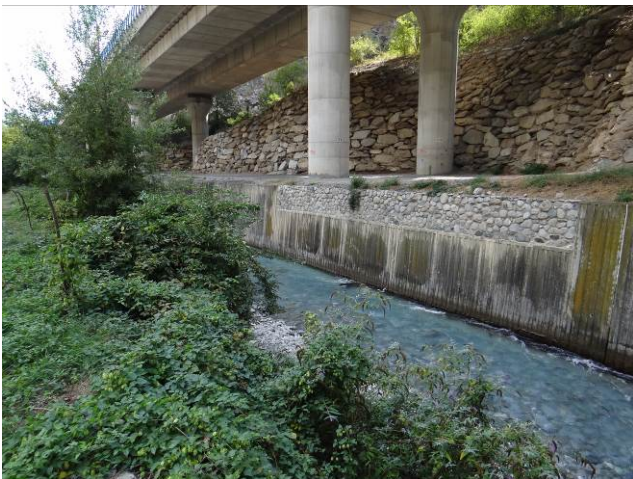
Mompanero: difese spondali in corrispondenza del ponte della A32.
