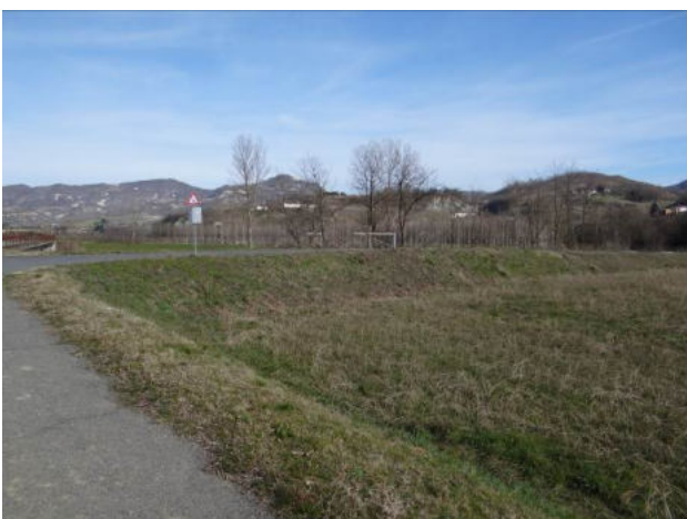
Alveo a valle del ponte per regione Cairo.
