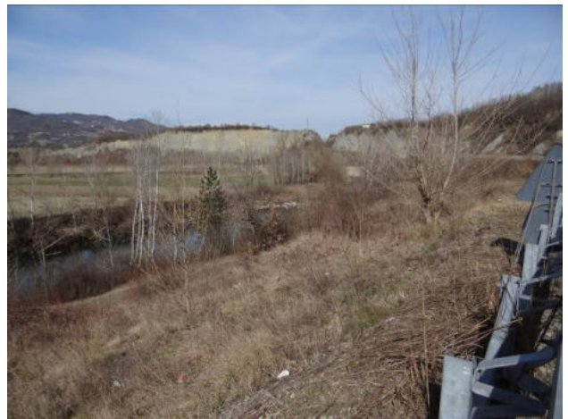
Alveo a valle di Mombaldone.
