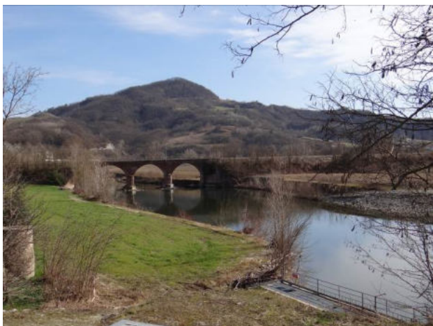
Ponte ferroviario nella parte terminale del tratto.
