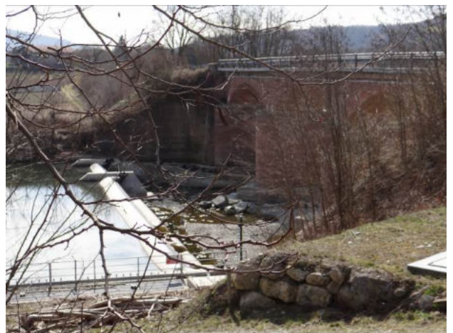
Traversa a monte del Ponte della SS30.
