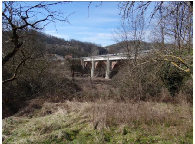
Ponte della SP 30.
