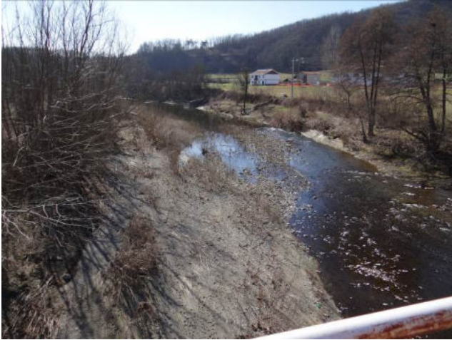
Alveo a monte del ponte di Merana.
