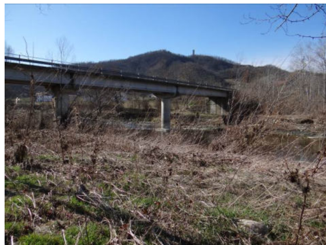
Ponte con pile in alveo a Merana .
