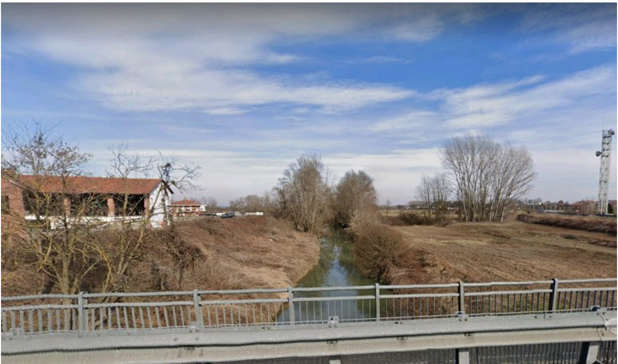
Argini in sponda destra e sinistra visti dal ponte di Via Torino a Poirino (Immagine Streetview, febbraio 2021)
