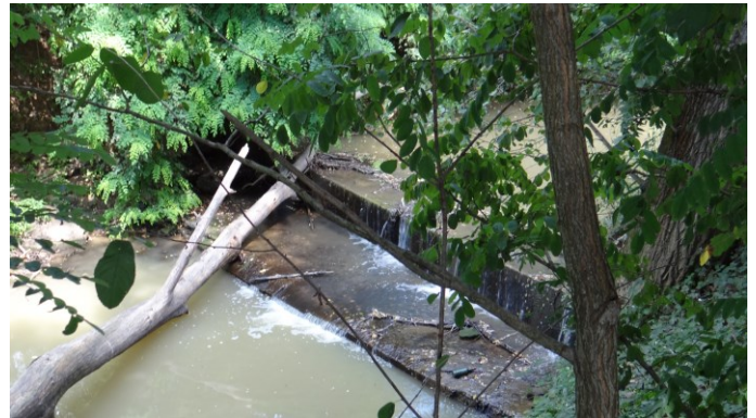
Soglia a valle del ponte di Strada del Tamagnone dove si riconosce un tronco in alveo, ma la foto è del 14/8/2018.
