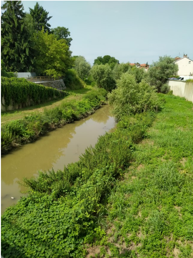
Difese di sponda e argini nel centro di Santena.
