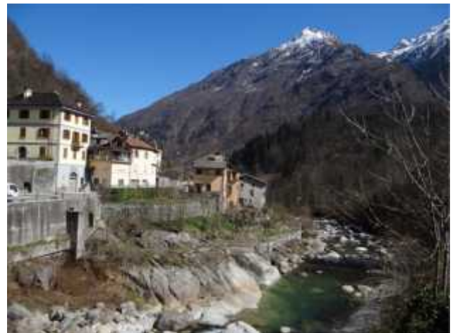
Alveo a valle ponte di Pontegrande
