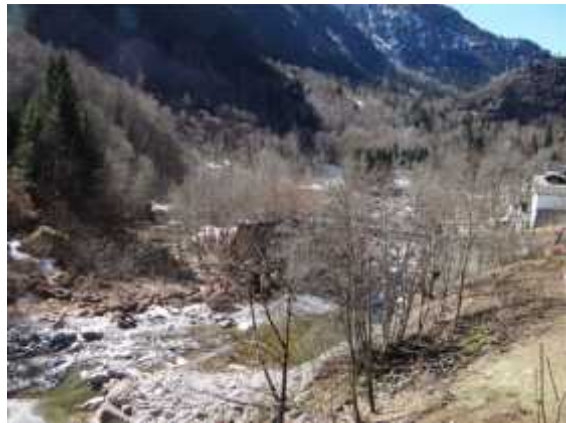
Ponte interferente con corridoio fluviale
