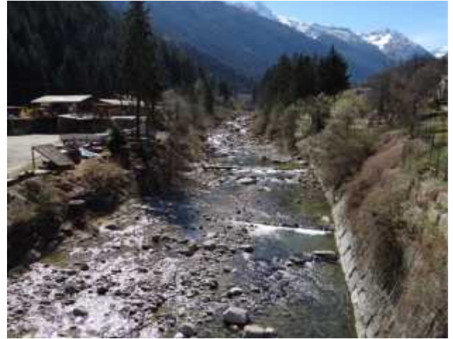
Pianezza - soglie e difese spondali in sinistra idrografica
