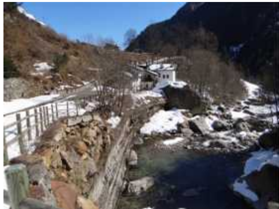
Difesa spondale in sinistra subito a valle del ponte di Pestarena
