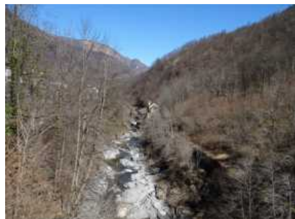
Alveo in roccia a valle della traversa
