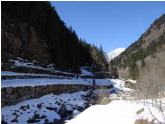
Serie di difese spondali in destra idrografica a monte ponte Pestarena
