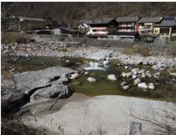
Soglia e muro di difesa a Pontegrande
