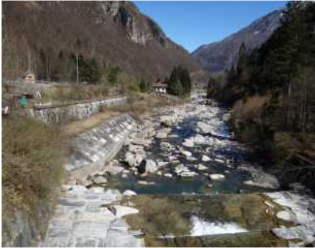
Pianezza - soglie e difese spondali in sinistra idrografica
