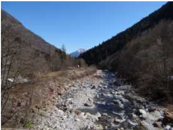
Argine in sponda idr. sinistra
