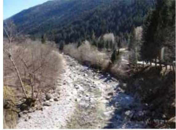
Difesa spondale in destra idrografica a valle del Ponte Prea di Ceppo Morelli
