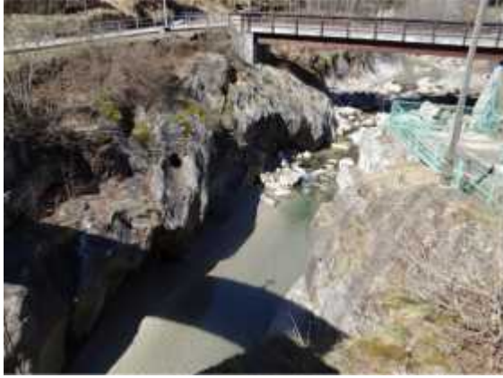
Sullo sfondo ponte senza pile che potrebbe però interferire con le portate di piena. In primo piano sponde in roccia e sul fondo alveo accumulo di materiale fine legato alle operazioni di svasso della Diga di Ceppo Morelli.
