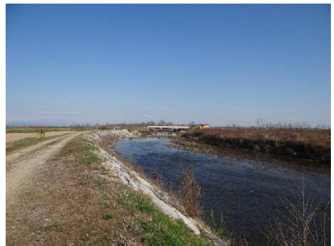
Argine in sponda destra.
