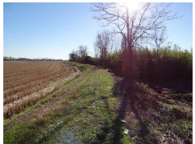
Argine in sponda sinistra.
