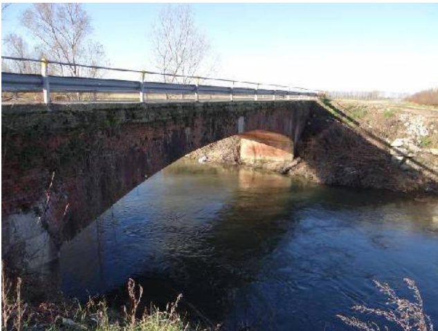
Ponte della SP N.78.
