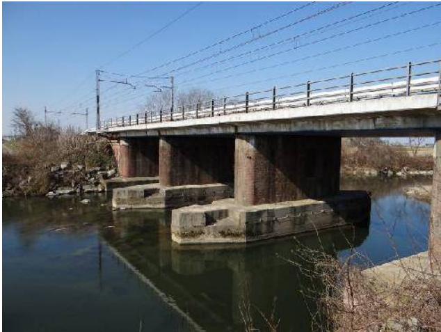
Il ponte ferroviario linea Vercelli-Novara.
