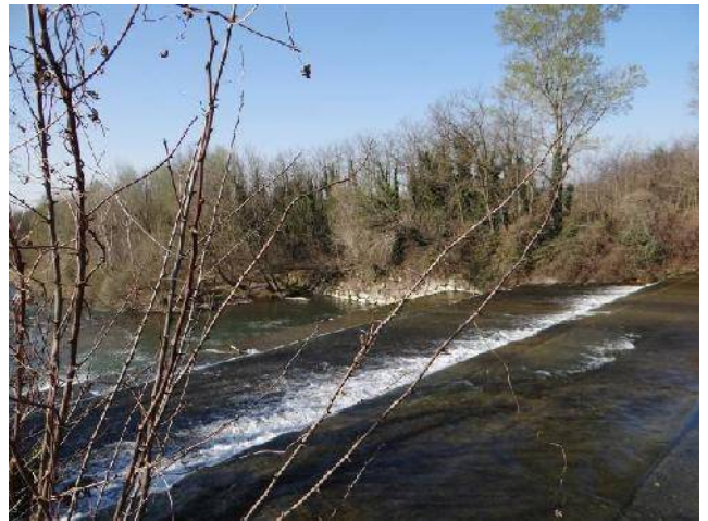
Il salto di 6 metri in corrispondenza della traversa di derivazione.
