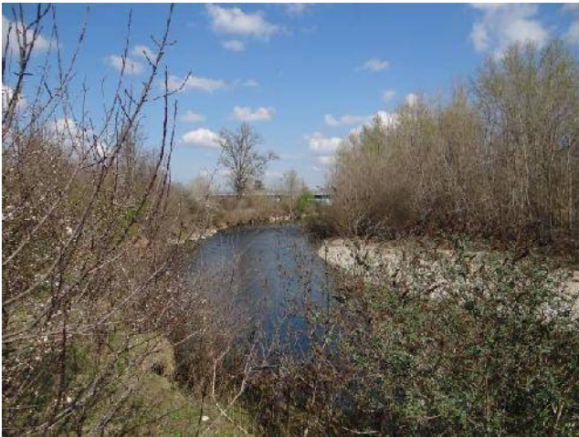
Alveo a valle del viadotto ferroviario linea ad alta velocità.
