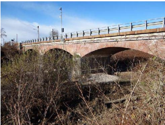
Ponte della SP 17.
