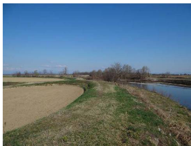
Argine in sponda destra all'entrata del canale Mora.
