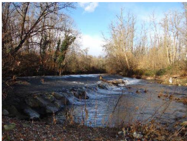
Traversa di derivazione in loc. M.o Torretta.
