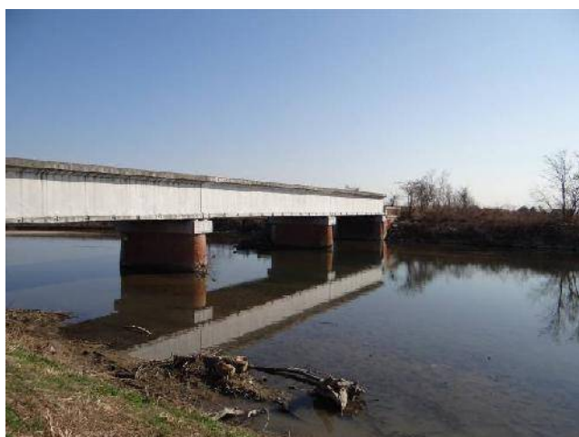
Ponte ferroviario ex linea Varallo-Novara.
