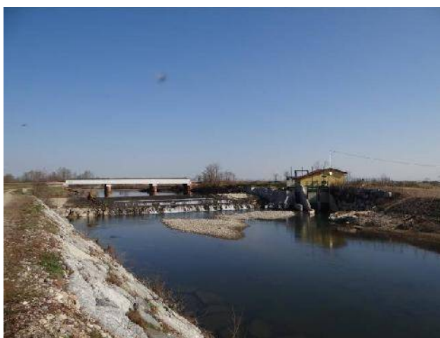
Traversa di derivazione continuazione della Roggia Mora.
