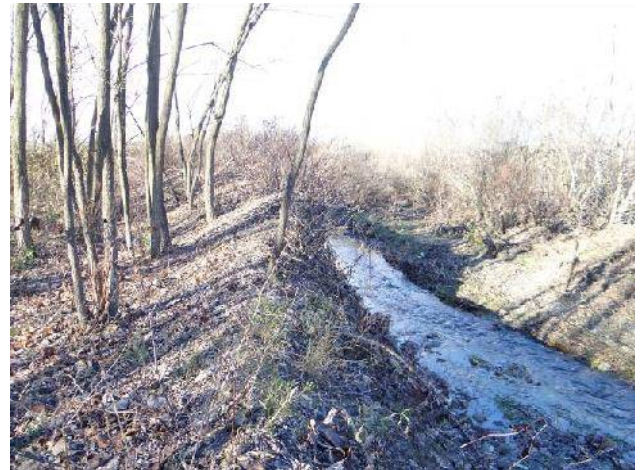
Arginatura in sponda sinistra appena a valle della traversa.
