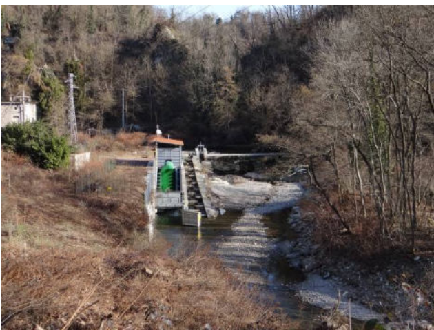
Opera di derivazione in prossimità della fine del tratto.
