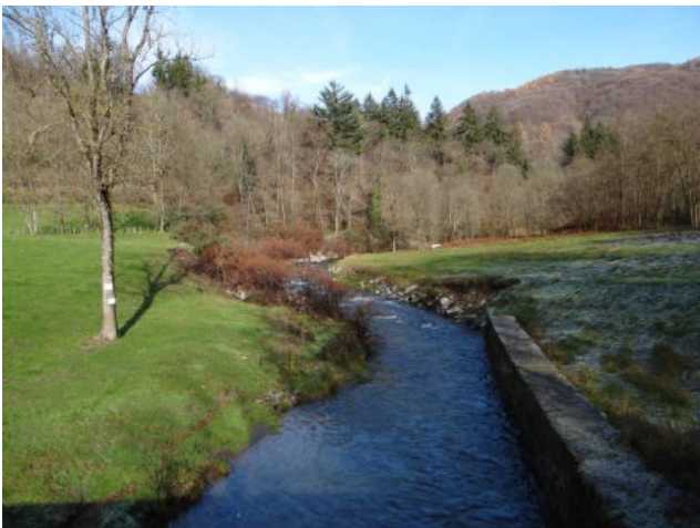
Alveo a monte del ponte della S.P. 22.
