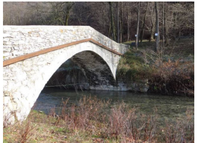
Il ponte della S.P.22.
